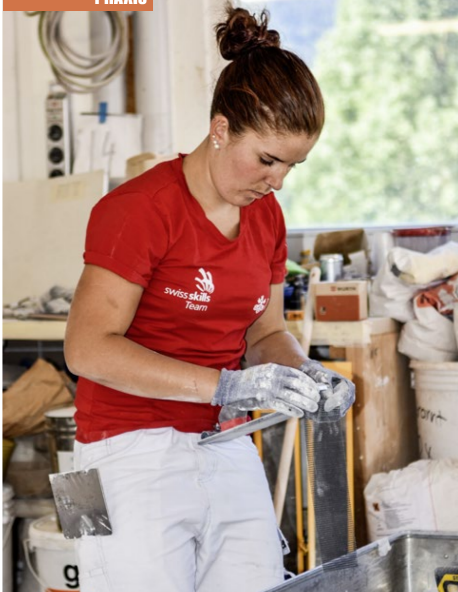
Das geeignete Werkzeug: Fabienne wechselt das grobe gegen ein feineres Schleifgitter.
