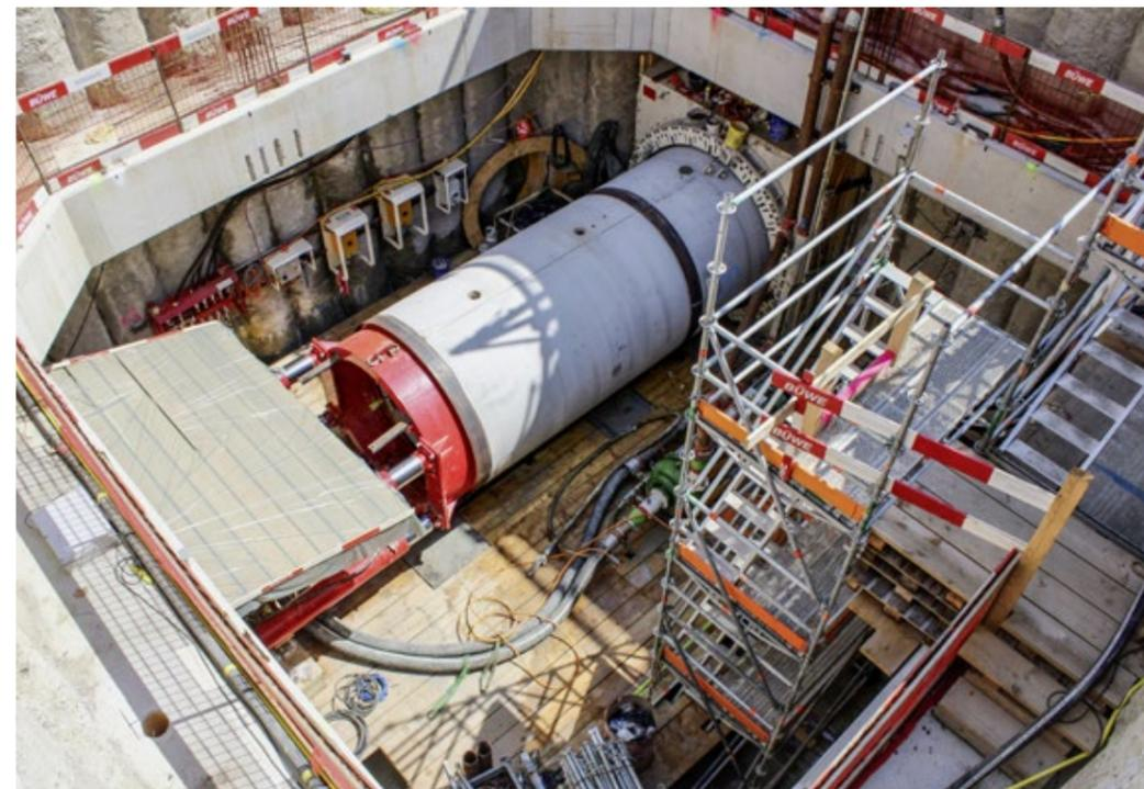
Die Schächte – auf dem Bild ist der Aabachstrasse-Schacht zu sehen – sind elf Meter tief und damit im Grundwasser.
