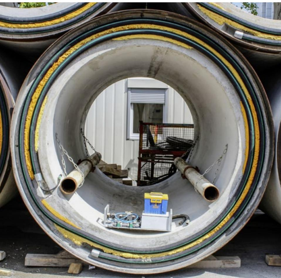
Die 4 Meter langen Rohrelemente sind aus Stahlbeton gefertigt. Ihr Aussendurchmesser beträgt 2,7 Meter, der innere 2 Meter. Ihr Gewicht liegt bei 25 Tonnen pro Stück. Sie sind bereits mit einer Förder- und Speiseleitung ausgestattet, die mit Schnellverschlüssen versehen sind. So können sie unten im Schacht rasch verbunden und auseinandergenommen werden.
