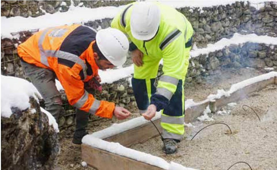
Mit einem langen Streichholz werden die Zündschnüre entflammt.
