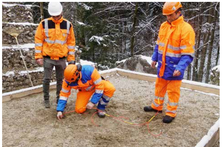
Lineares Zündsystem: Die Sprengschnur wird von einer Ladung zur nächsten geführt.
