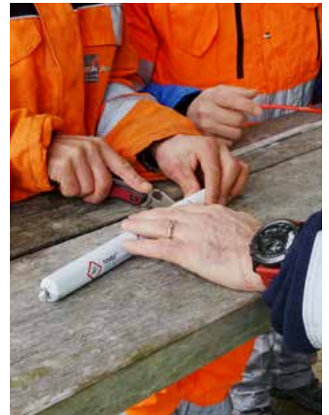
Eine Sprengpatrone wird zugeschnitten.
