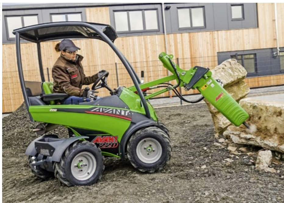
Auch die äusserst Kompakten lassen sich vielseitig nutzen: Ein nur 99,5 Zentimeter breiter und 700 Kilogramm schwerer Avant 220 mit pfiffiger Knicklenkung zerkleinert mit dem Hydraulikhammer Betonreste.
