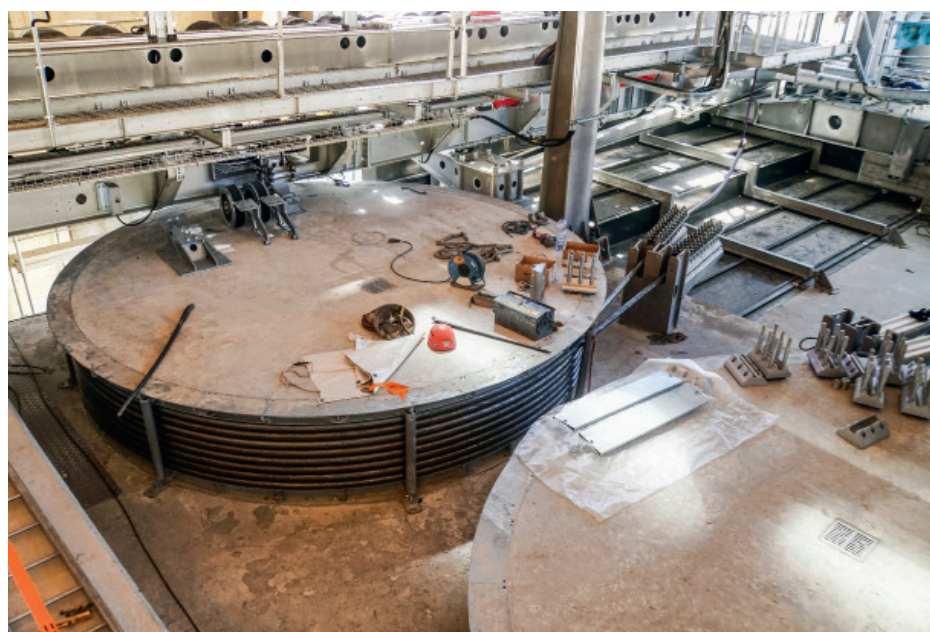
Links oben: Die Bremswirkung in der Station wird mit dem axial angeordneten Räderwerk erreicht, dessen Drehgeschwindigkeit automatisch mit der Umlaufgeschwindigkeit des Förderseils synchronisiert ist. Der Bremsvorgang entsteht, indem die weiter hinten liegenden Räder immer langsamer drehen. Umgekehrt verhält es sich bei der Beschleunigung. Wegen der physikalischen Kräfte der tonnenschweren Gondeln ist das Räderwerk entsprechend lang.
