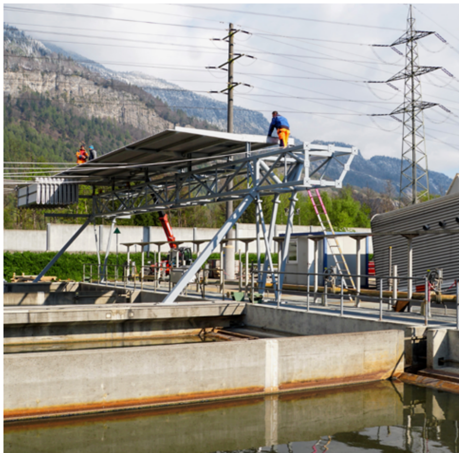
Seilbahnbau in der Churer Abwasserreinigungsanlage: Für das vollautomatische Solar-Faltdach laufen Ende April die Montagearbeiten in ungewohnter Umgebung.
