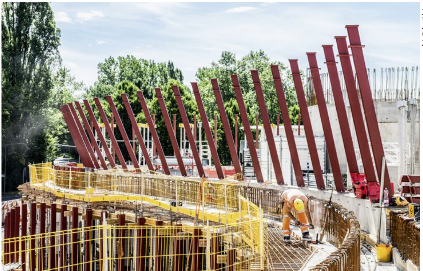
Die Stützen sind 912 mm bis 4330 mm lang und in Winkeln von bis zu 30 Grad angeordnet. So bilden sie die Wellenform des Gebäudes.
