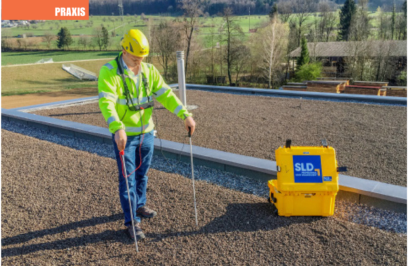
Leckortung auf einem bekiessten Dach: Verändert sich die Feuchtigkeit auf dem Draht des eingebauten Ringsystems, wird dies von den Messgeräten angezeigt.
