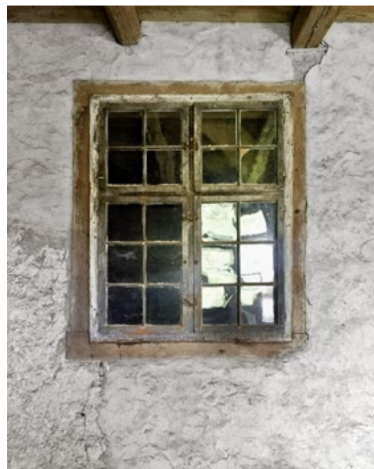
Noblesse im alten Gemäuer: Dieses Fenster zur grosszügigen Laube ist teilweise bleiverglast.
