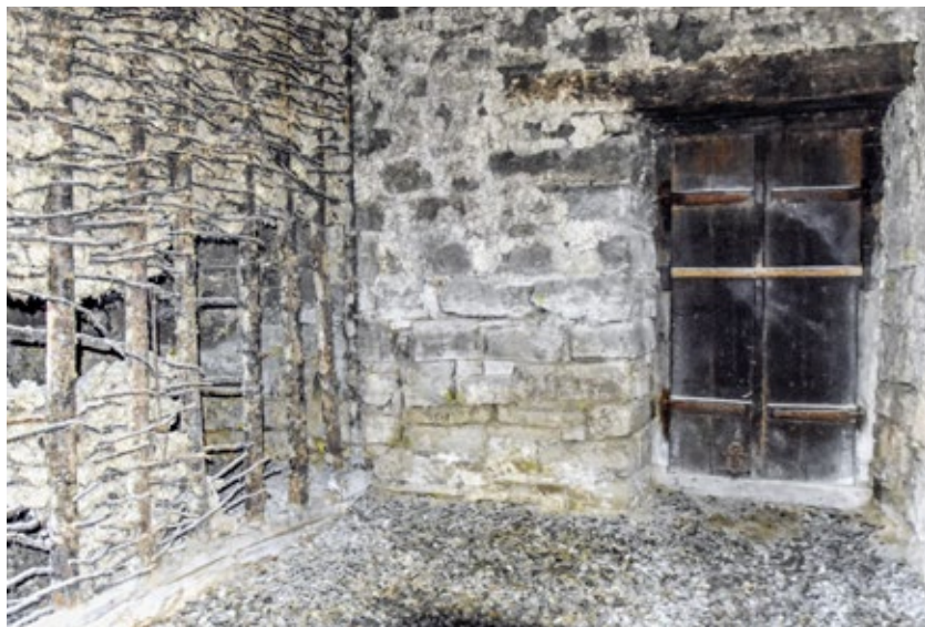
Leichtbau: Das Material der lehmverstrichenenen Rutenflechtwände ist gewichtsparend und stammt aus der Region.
