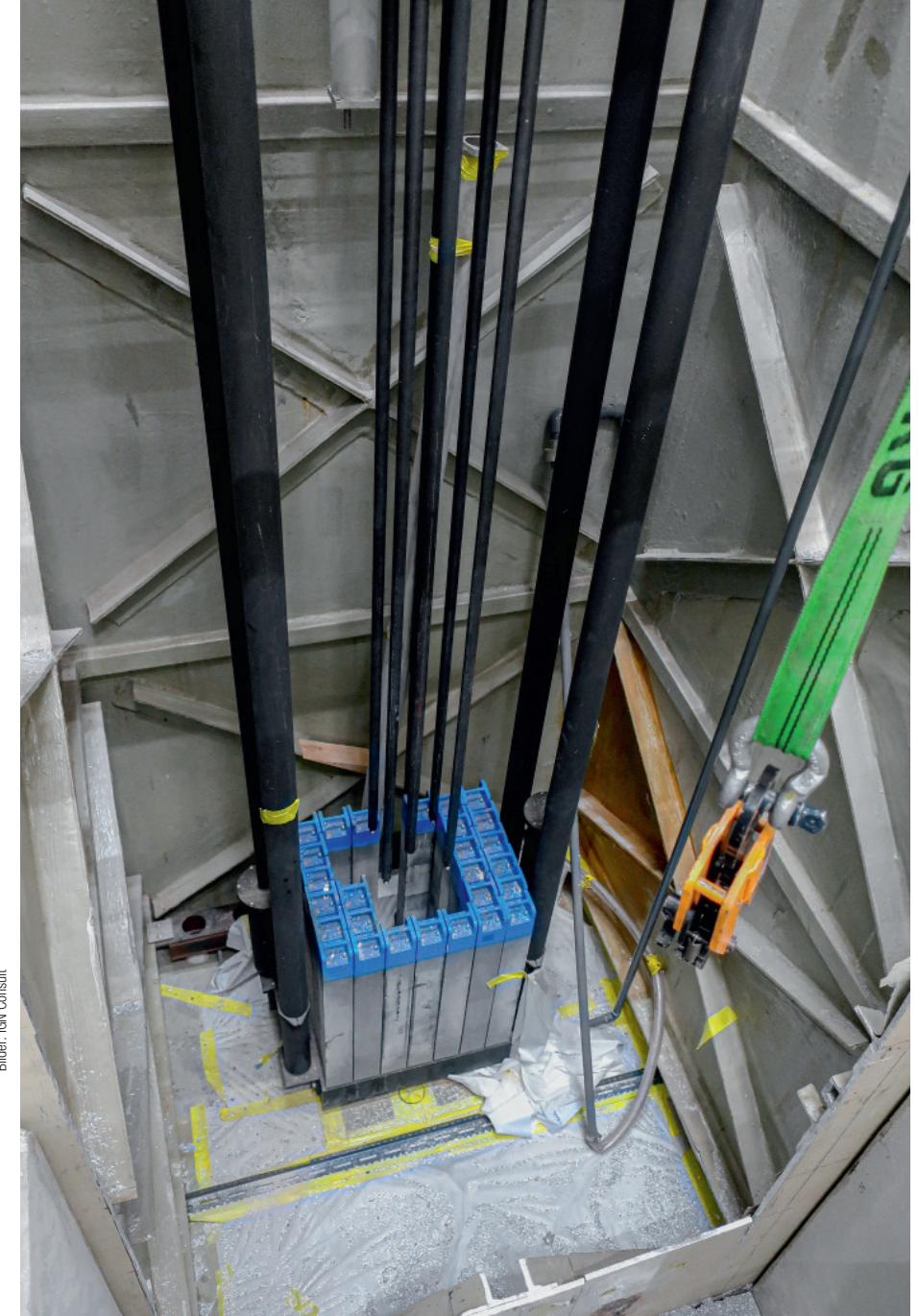
Aufgeschnittener Reaktortank mit Blick auf das Core.
