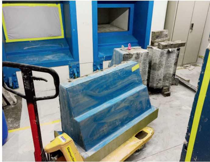
Zerlegung der Safetüren.
