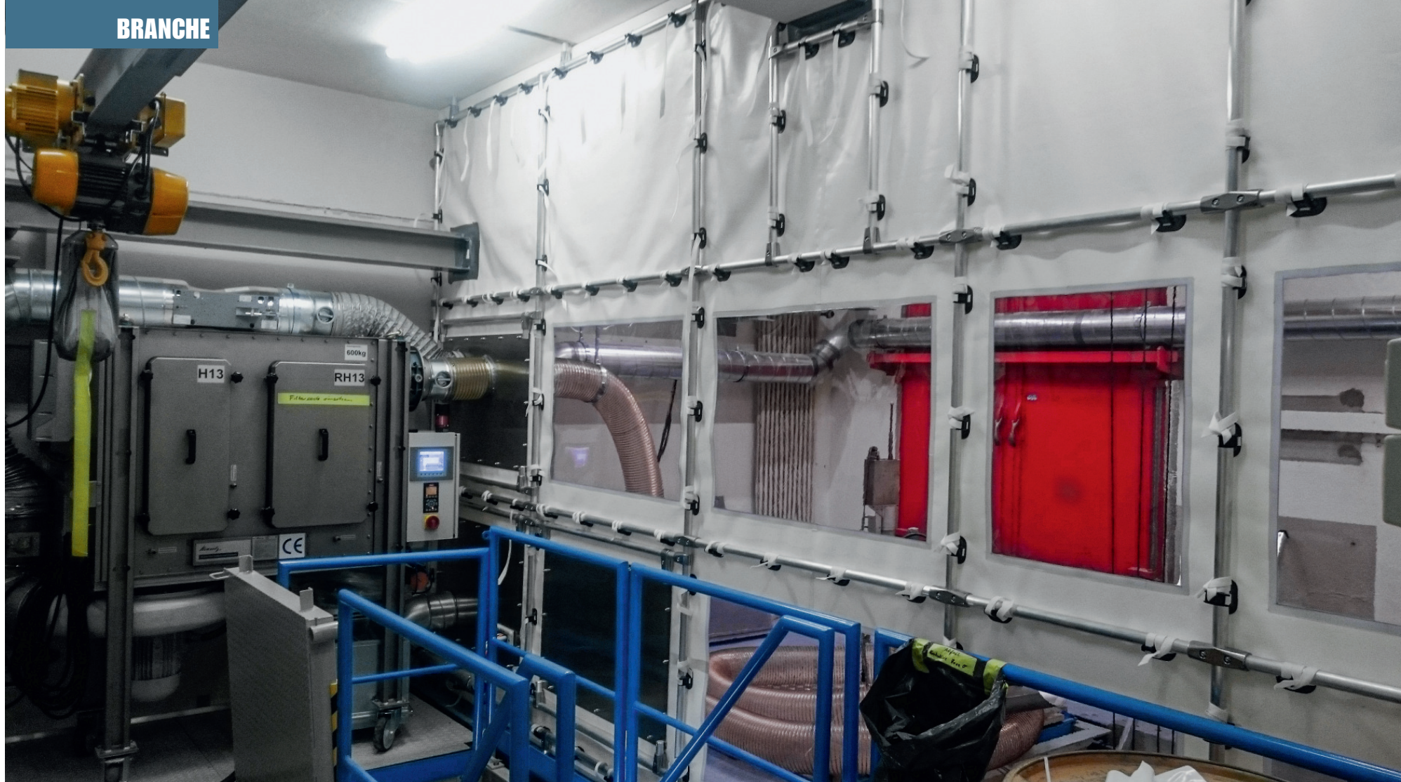
Vorbereitung der Demontage mit installierten Hilfseinrichtungen. Da es sich um einen Reaktor mit geringer Leistung handelt, ist der Abbau recht zügig möglich.
