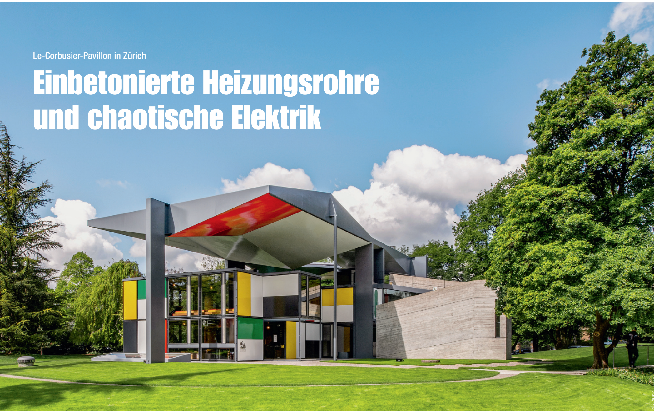
Auf der vom Dach geschützten Nordseite stammen fast alle Scheiben aus der Bauzeit. An der ungeschützten Südseite liess Heidi Weber regelmässig blind gewordene Scheiben ersetzen. (Bild oben) Blick vom Dach auf den Eingangsbereich. Die Emailplatten folgen einem von Le Corbusier vorgegebenen Rhythmus. (Bild links)
