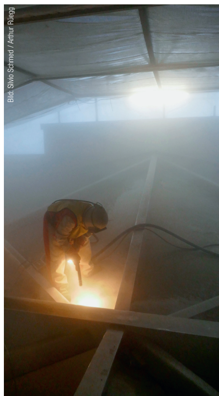
Die PCB-kontaminierten Farbschichten wurden in luftdichter Einhausung sandgestrahlt.
