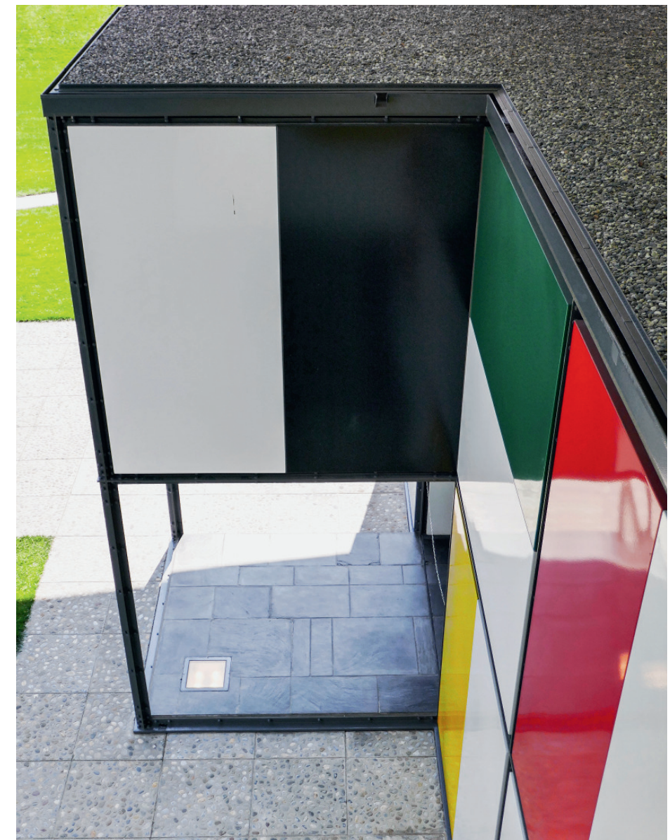
Auf der vom Dach geschützten Nordseite stammen fast alle Scheiben aus der Bauzeit. An der ungeschützten Südseite liess Heidi Weber regelmässig blind gewordene Scheiben ersetzen. (Bild oben) Blick vom Dach auf den Eingangsbereich. Die Emailplatten folgen einem von Le Corbusier vorgegebenen Rhythmus. (Bild links)
