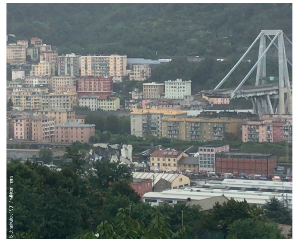
Die 1182 Meter lange Morandi-Brücke in Genua, mit offiziellem Namen Viadotto Polcevera, wurde 1967 eröffnet. Am 14. August 2018 stürzte ein 200 Meter langes Stück der vorgespannten Stahlbetonbrücke ein, wobei 43 Menschen ums Leben kamen. Die Ermittlungen der Bauforsiker zur Ursache des Einsturzes sind noch im Gange, doch gab es schon lange Hinweise auf Mängel bei der Bemessung der Statik. Zudem hat man vermutlich dem Beton zuviel Sand beigemischt.
