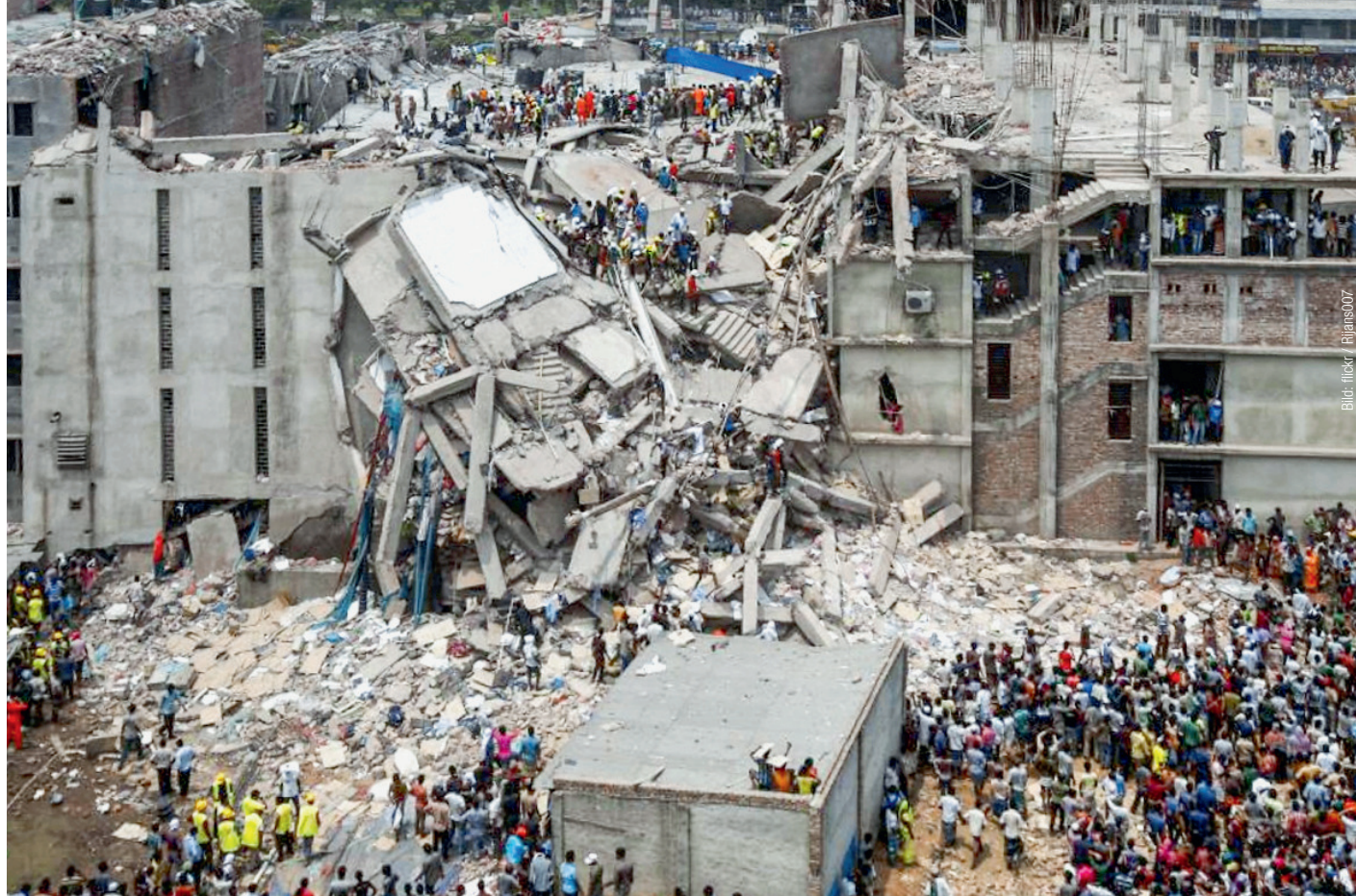
Der Einsturz dieser Textilfabrik in Sabhar (Bangladesh) im Jahr 2013 forderte 1135 Menschenleben. Untersuchungen ergaben, dass grobe Fahrlässigkeit und die Verwendung minderwertiger Materialien beim Bau der Fabrik die Ursache für die Katastrophe waren.
