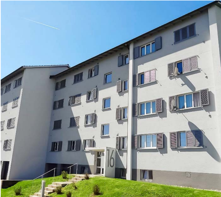
Gebäude aus dem Immobilien-Portefeuille der Credit Suisse, das in die energetische Betriebsoptimierung einbezogen wurde.
