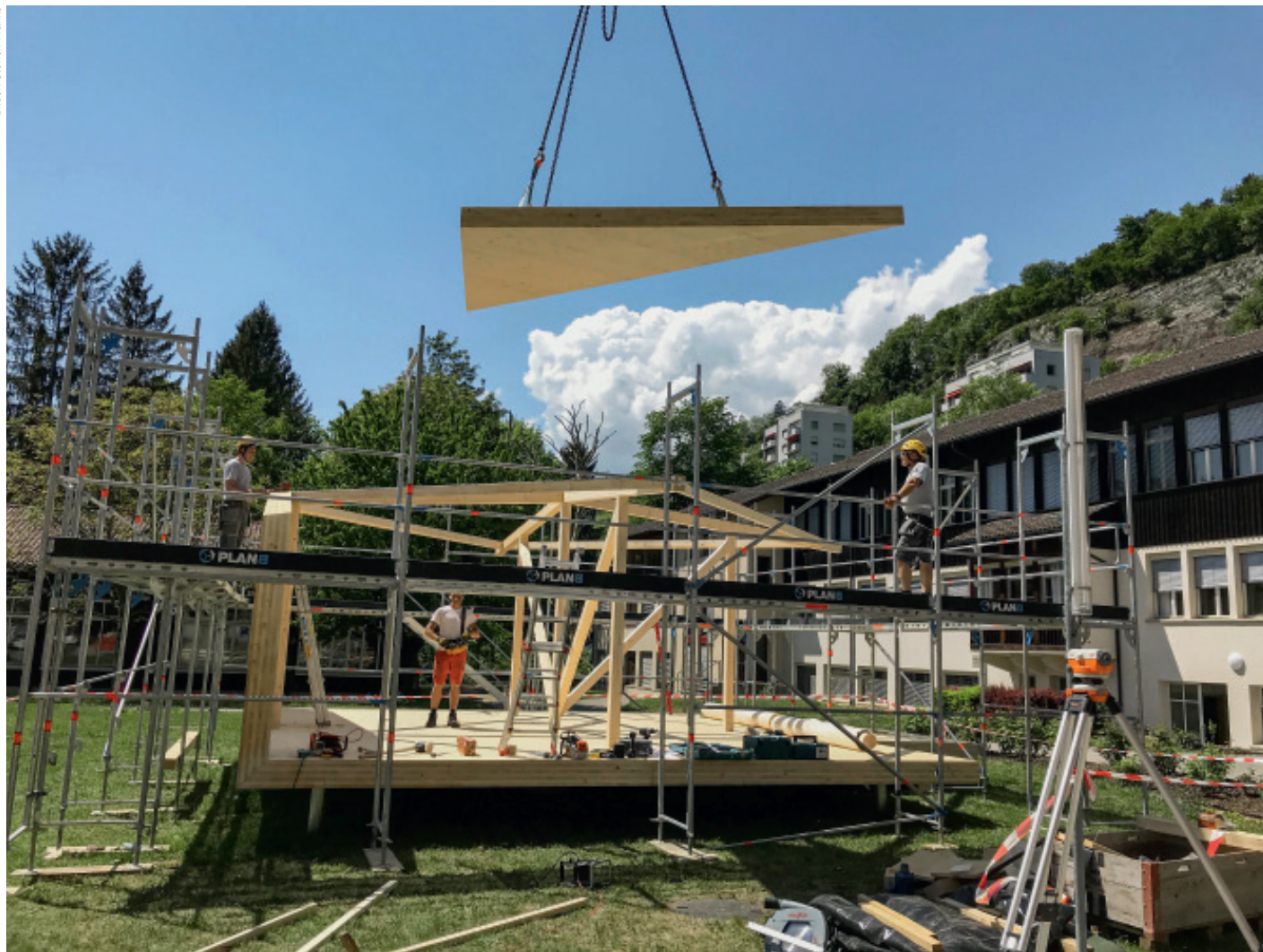
Das erste Dachelement wird auf das Lehrgerüst versetzt. Die Decke und Wand sind bereits verklebt und ohne Abstützungen.
