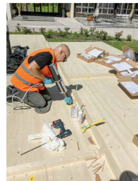
Verguss der abgedichteten Fuge der Deckenplatten.
