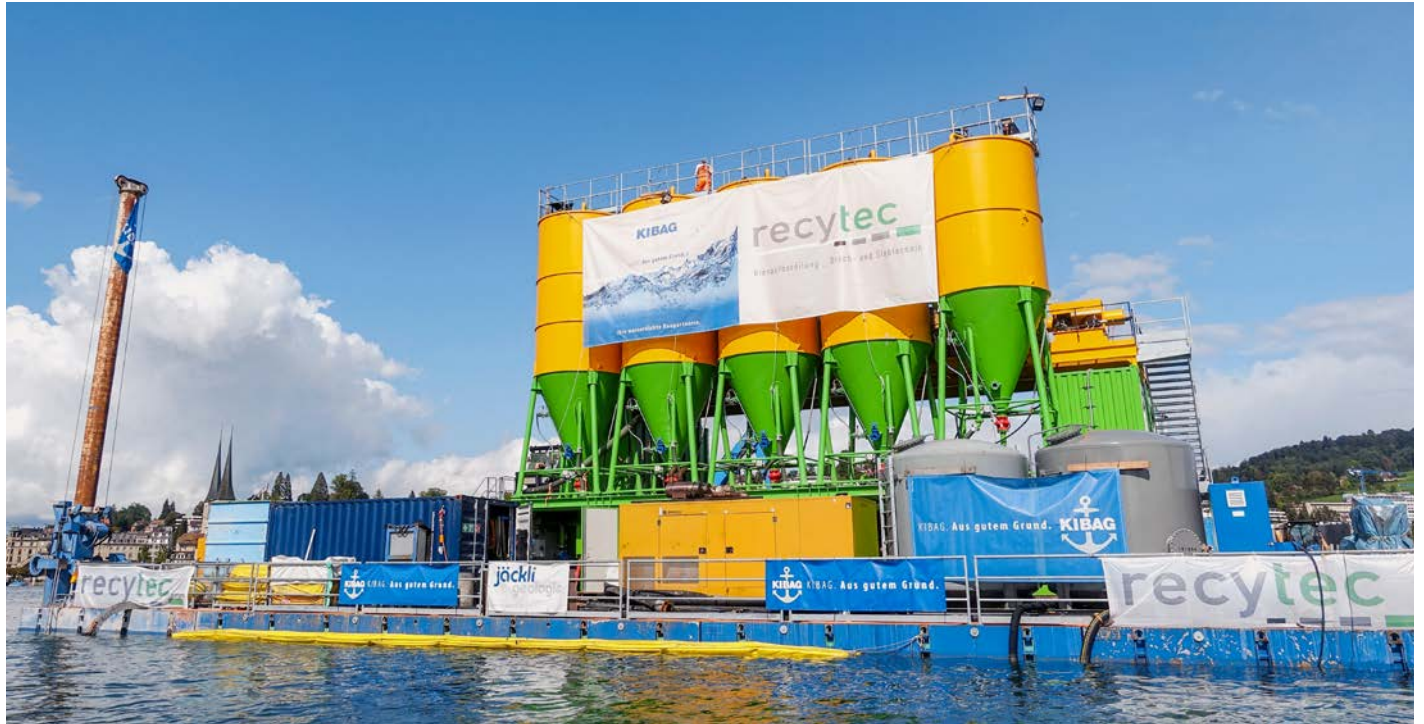
Weithin sichtbar stehen fünf 14 Meter hohe Silos auf der 900 Quadratmeter grossen Plattform, die Pontons zusammengesetzt wurde.
