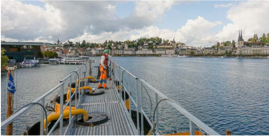
Luzia Balmer überwacht auf einer Plattform an der Spitze der Silos den Förder- und Reinigungsprozess. Wird zu schnell viel Material gefördert, lässt sie kurzzeitig das Absaugen stoppen.
