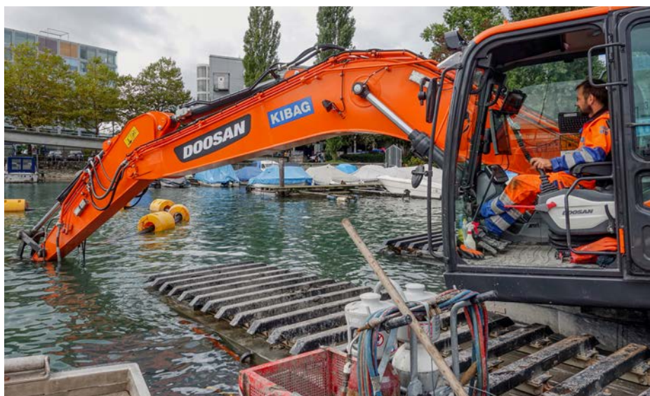
Langsam fährt der Arm des Saugbaggers über den Seegrund, um die abgelagerten Sedimente zu entfernen. Durch Schwebstoffe ist die Sicht behindert, doch mithilfe des Bildschirms kann der Arbeitsprozess in Echtzeit überprüft werden.
