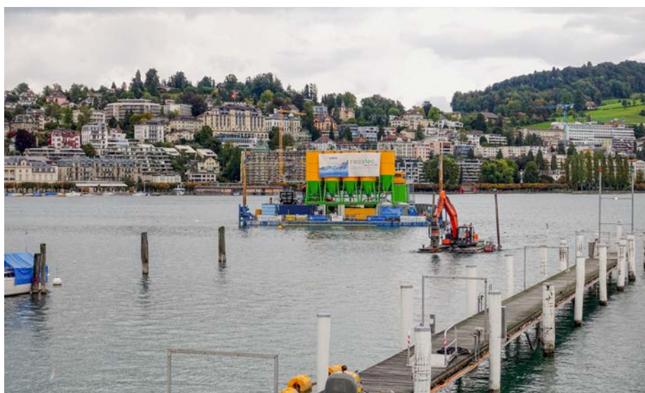
Der schwimmende Bagger auf dem Weg zu seinem Einsatzort neben dem Inseli. Im See liegt die Aufbereitungsanlage, auf der die ausgebagerten Sedimente zur Weiterbehandlung getrennt und entwässert werden.
