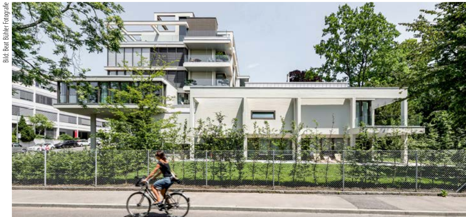
Bei der ehemaligen Verbandszentrale in Zürichs Quartier Seefeld blieb das äussere Erscheinungsbild weitgehend unverändert.
