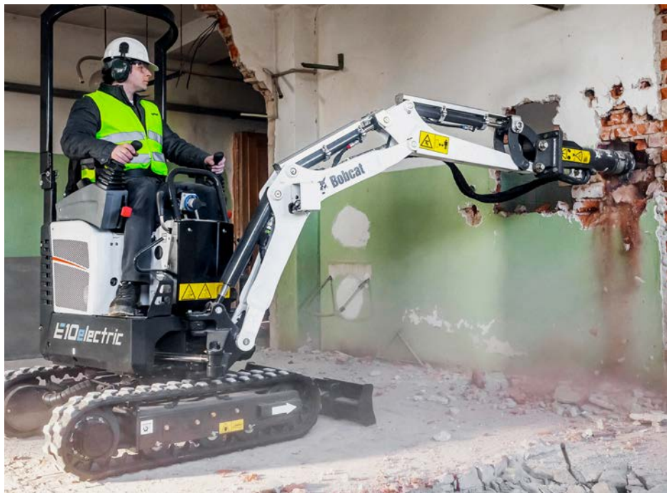
Mikrobagger sind nützlich nicht nur bei Innenarbeiten. Es gibt immer mehr elektrische Modelle wie diesen Bobcat E10electric.
