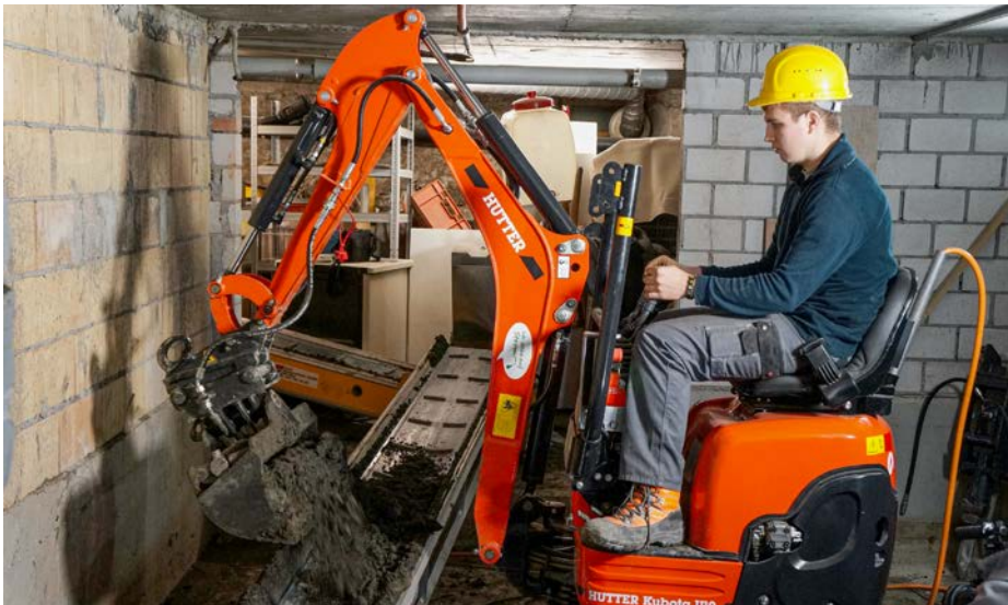
Zwei technische Entwicklungen bei Mikrobaggern zeigen sich am Hutter Kubota U10-3: die Kurzheckbauweise und der elektrische Antrieb.
