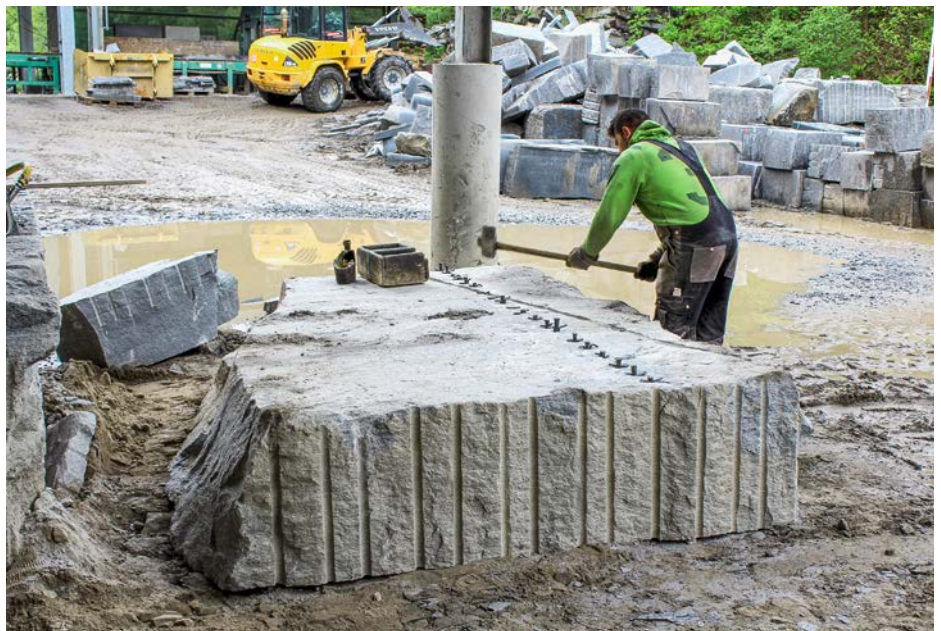
Naturstein mit dem Lager lässt sich mit geringerem Kraftaufwand spalten. Nach wenigen Schlägen des Vorschlaghammers auf die gesetzten Nägel zerbricht der Gneisblock zu kleineren Quadern.
