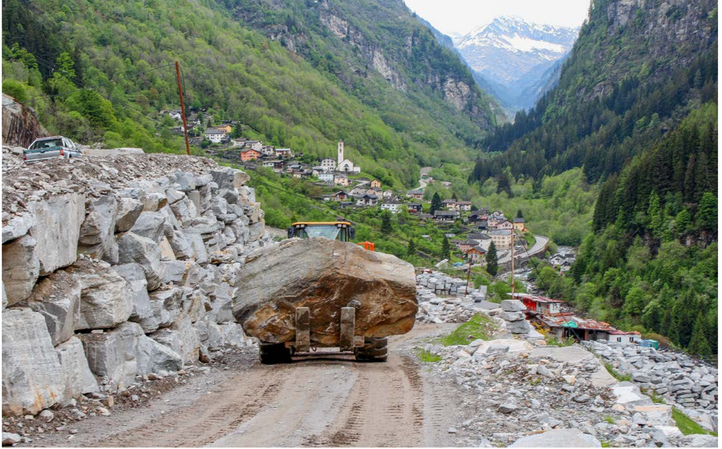
Von der Abbruchstelle im Calancatal in der Nähe von Arvigo werden die Felsblöcke zunächst in ein Zwischenlager transportiert.
