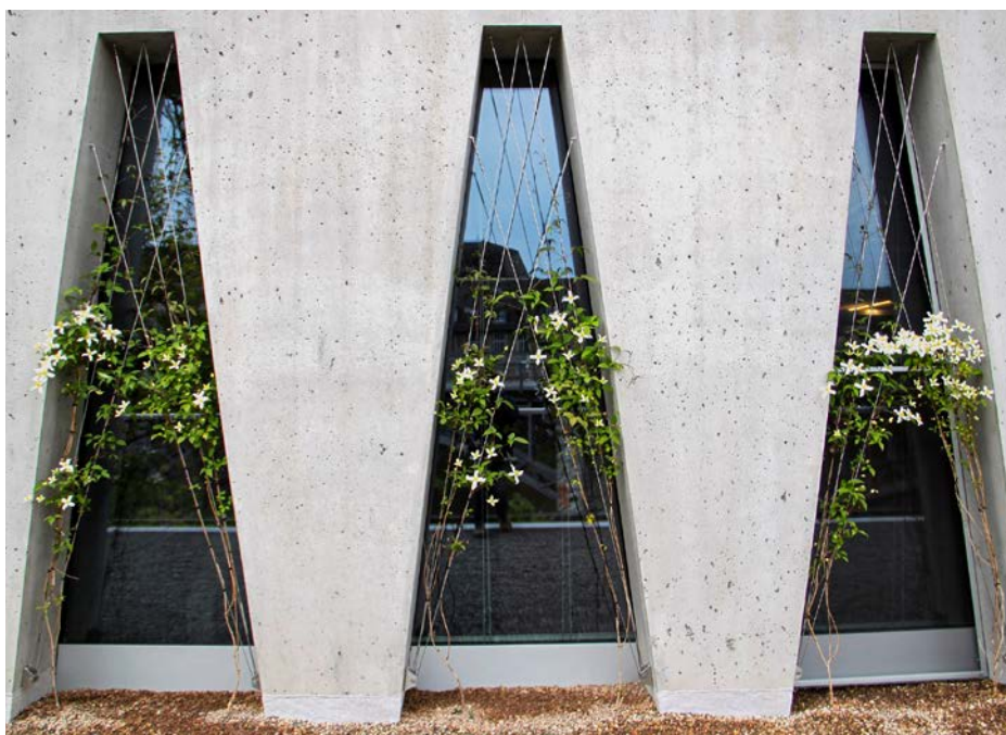
Dämmbeton beim neuen Tanzhaus in der Stadt Zürich: Bei diesem Zweckbau im Minergie-Eco-Standard dient die Aussenwand aus Leichtbeton mit dem Zusatzstoff Blähton als Wärmedämmung.
