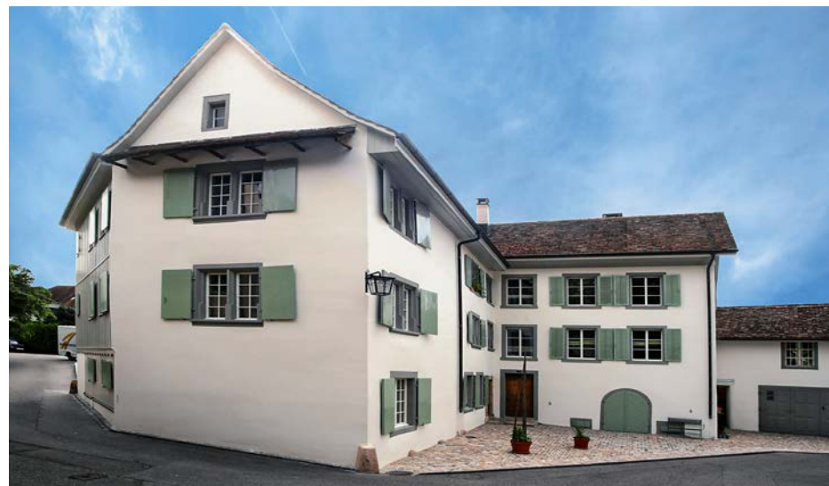
Die alte Mühle in Sissach BL, die aus dem 15. Jahrhundert stammt, wurde mit einem Aerogel-Hochleistungsdämmputz energetisch saniert – ohne deren Charakter zu verändern.
