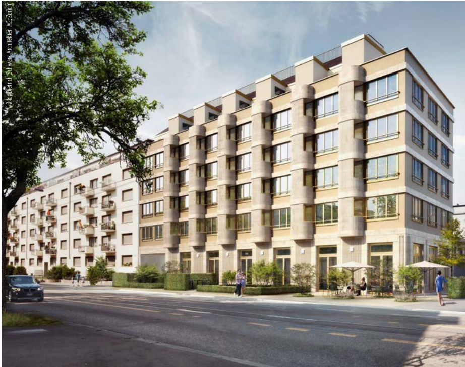
Dem Mehrfamilienhaus an der Hohlstrasse 100 in Zürich ist heute von aussen nicht anzusehen, welche Hightech-Dämm Lösungen in ihm stecken.
