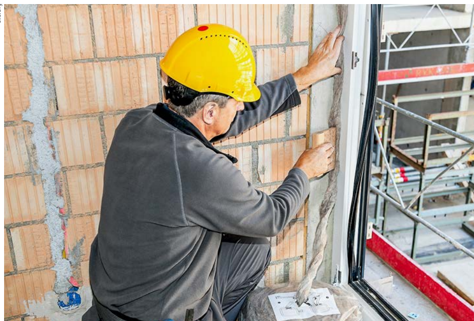
Als Fugenstopf kommt Schafwolle heute auch bei Fenster- und Maueranschlüssen zur Anwendung.
