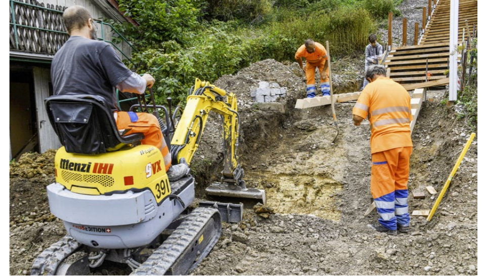
Ein Vorteil der Holztreppe ist, dass man sie relativ leicht demontieren kann, um an die darunter liegenden Werkleitungen zu gelangen.
