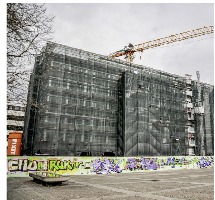
Im innerstädtischen Bereich stellen die Baustellenlogistik und der vorhandene Stellplatz oft grosse Herausforderungen dar.
