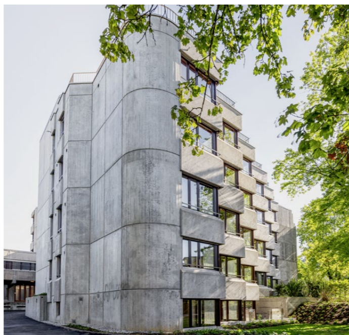
In der Regel ist eine Wohneinheit innert 25 Tagen saniert, wie hier bei einem von der Implenia sanierten Wohngebäude in Köniz BE.
