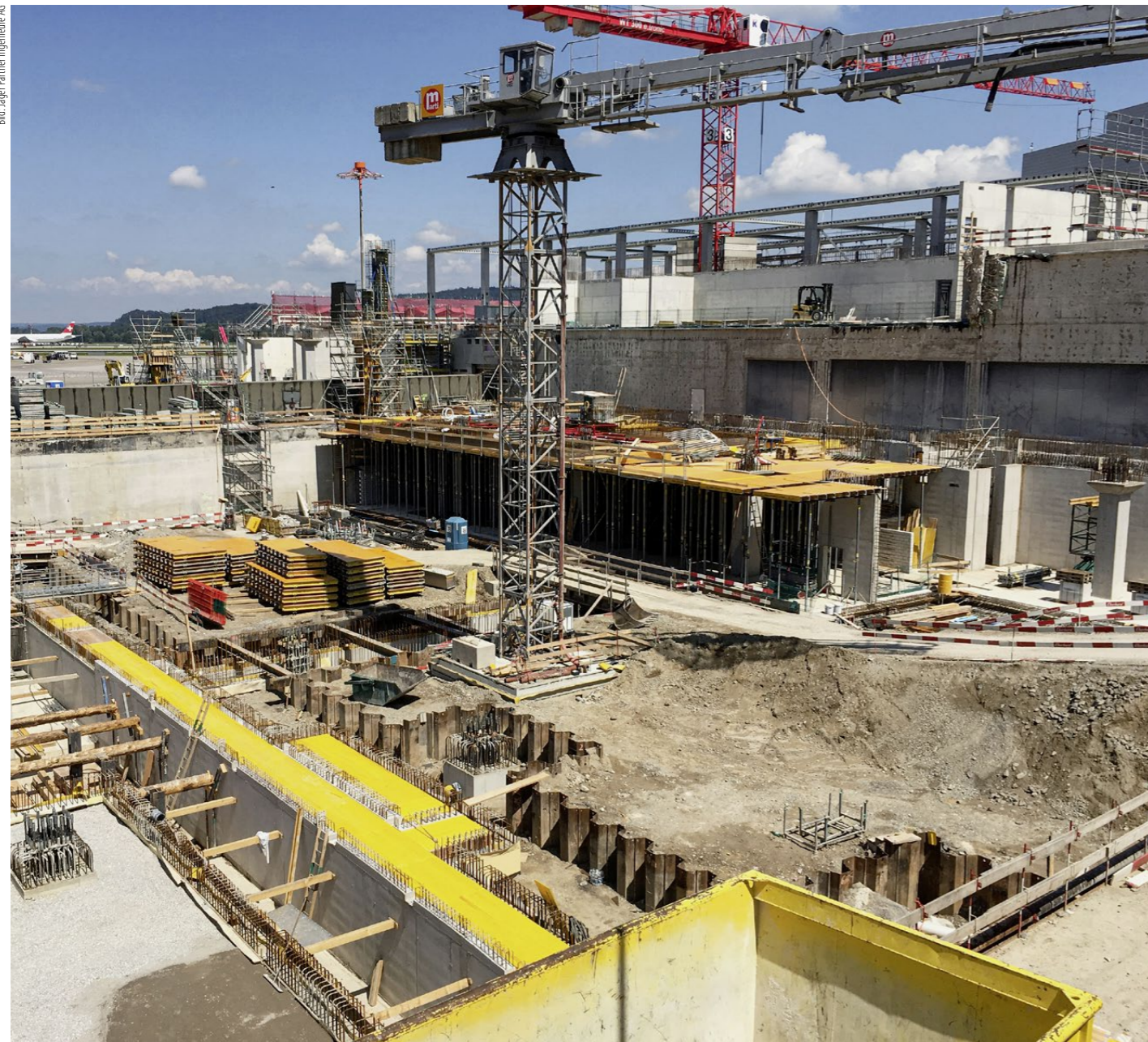
Vorne entsteht das Untergeschoss der neuen Gepäcksortieranlage, rechts der bestehende Frühgepäckspeicher, der teilweise rückgebaut und neu aufgestockt wird.
