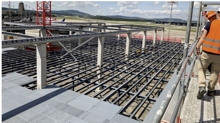
Leichte, tragfähige Decken und zugleich grosse Spannweiten ermöglicht das Slim-Floor-Deckensystem, das auf der Baustelle rasch montiert werden kann.
