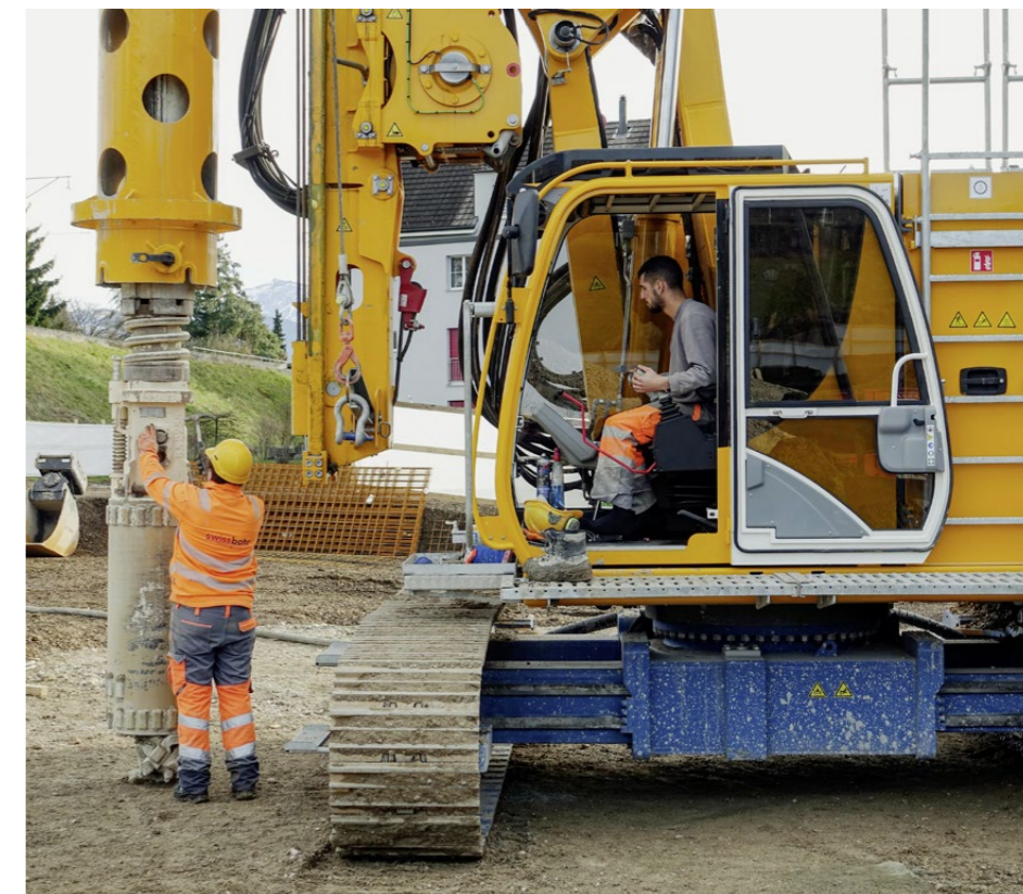
Das tonnenschwere Bohrwerkzeug wird gewechselt. Im oberen Bereich steht weicher Boden an. Sobald der Bohrer auf felsigen Untergrund stösst, muss der Bohrkopf erneut gewechselt werden.
