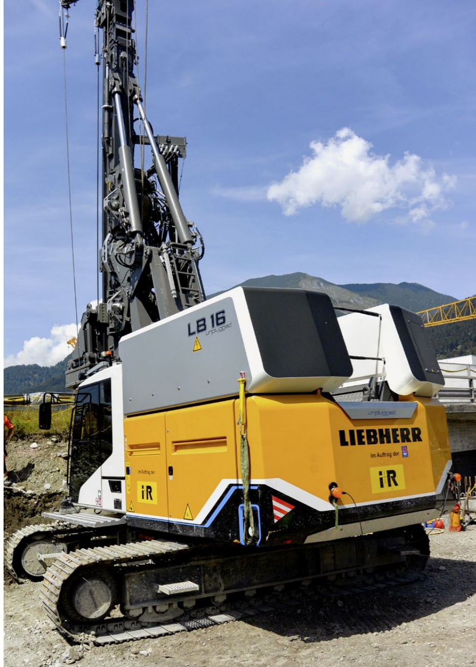
In Kooperation mit dem ETH-Startup Suncar HK entstand dieses mächtige, akkubetriebene Grossdrehbohrgerät vom Hersteller Liebherr. Weitere Einheiten sollen jetzt gebaut werden.
