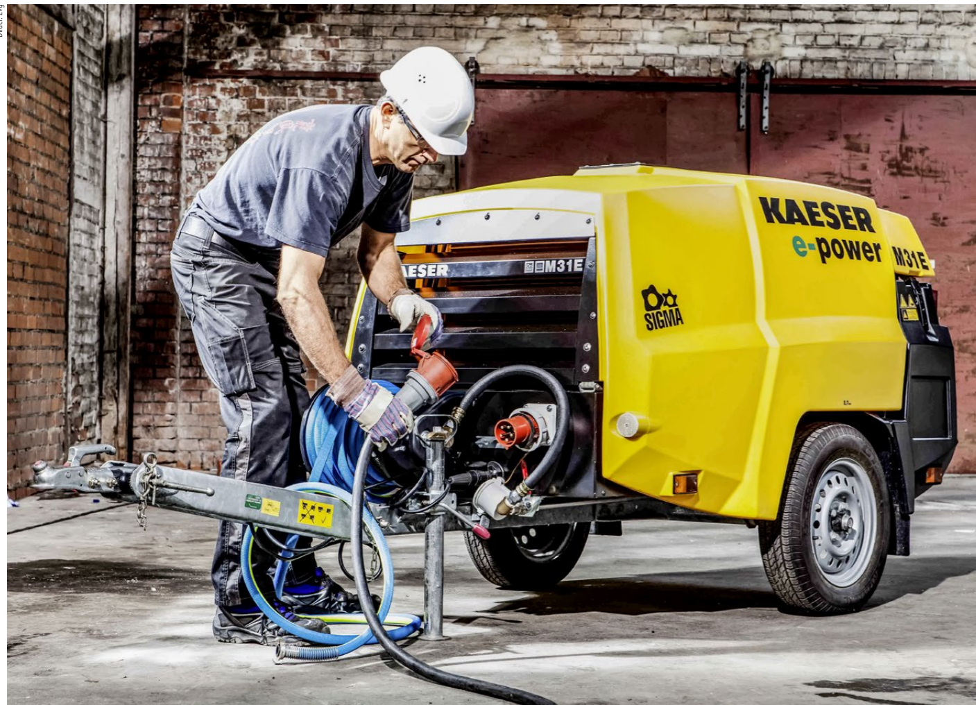
Mit elektrischen Baumaschinen und -geräten lassen sich mittlerweile komplette Baustellen einrichten. Selbst Kompressoren wie der Kaeser M31E machen die Arbeit im Innenbereich möglich.
