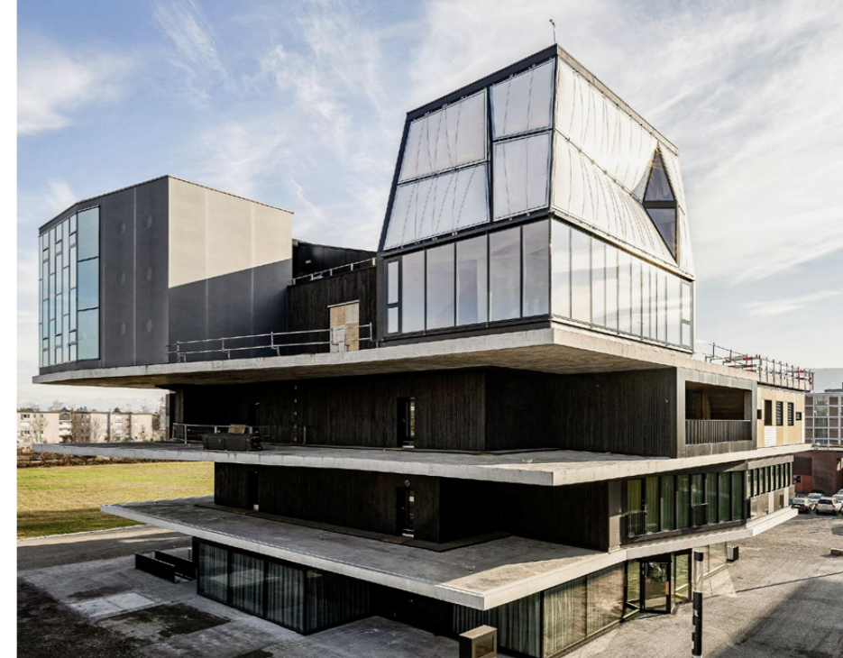
Das «DFAB House» der Empa und Eawag wurde grösstenteils von Robotern gebaut.
