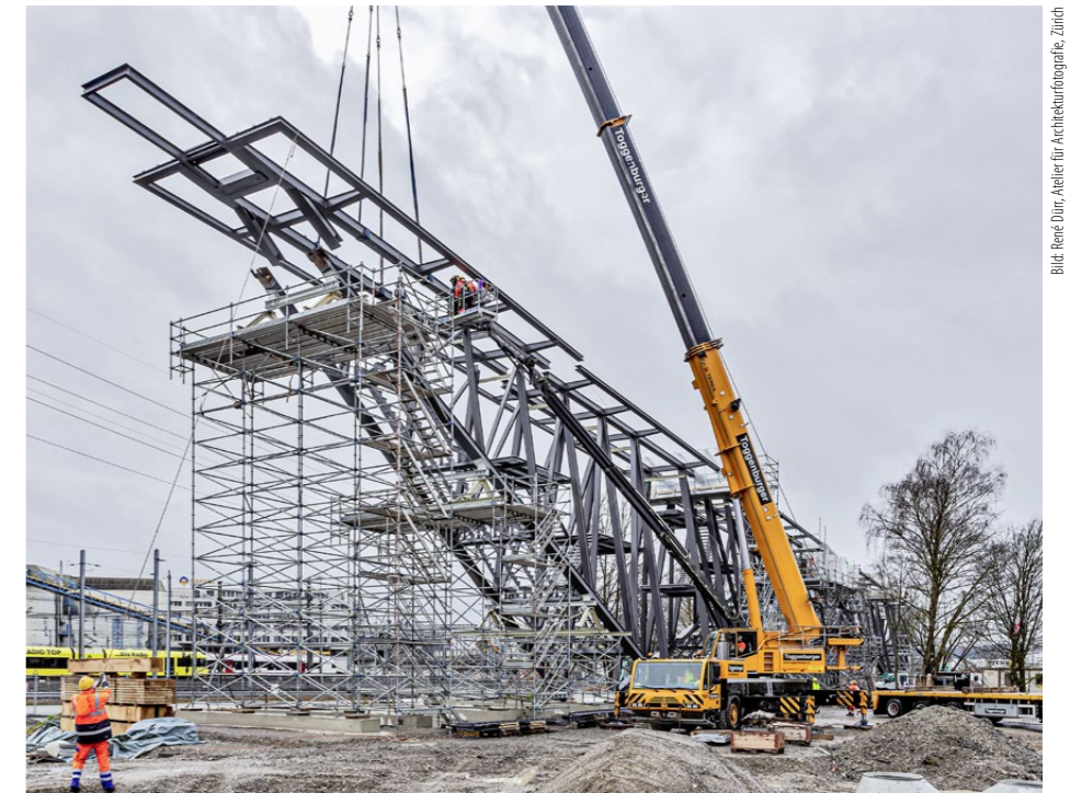
Bei der Montage der Brückenelemente wird die grosse Kragbühne per Pneukran an ihren luftigen Bestimmungsort 17 Meter über Boden gehievt.
