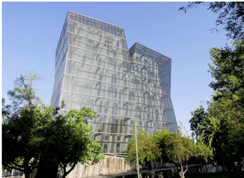
Bei den Siamesischen Türmen (2003) wird das Problem des Treibhaus-Effekts durch zwei Schichten gelöst. Die Glasverkleidung trotz Witterungseinflüssen. Die Luftschicht zwischen Aussenhülle und Gebäudestruktur wirkt isolierend und sorgt im Inneren für angenehme Temperaturen.
