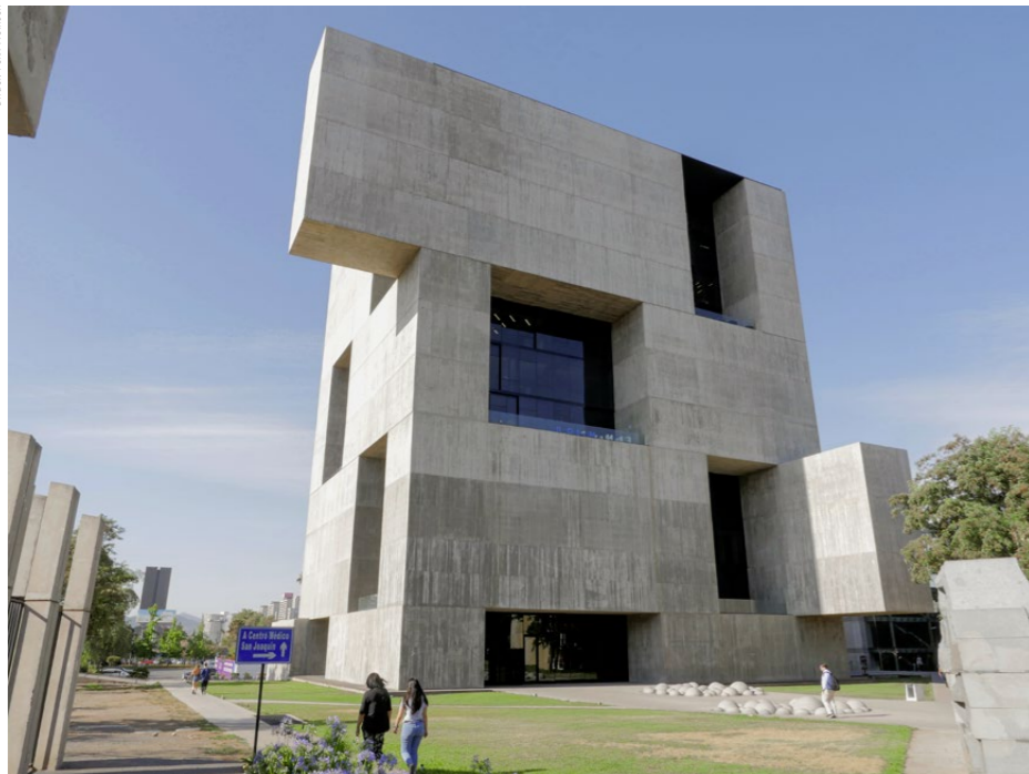
Das Gebäude des Innovation Center (2009) kommt ohne Klimaanlage und Heizungen aus. Damit hebt es sich von den vielen Glastürmen ab, die Santiago de Chile dominieren und im Sommer wie Treibhäuser funktionieren. Das massive Äussere steht im Kontrast zum hellen und offenen Innenraum.
