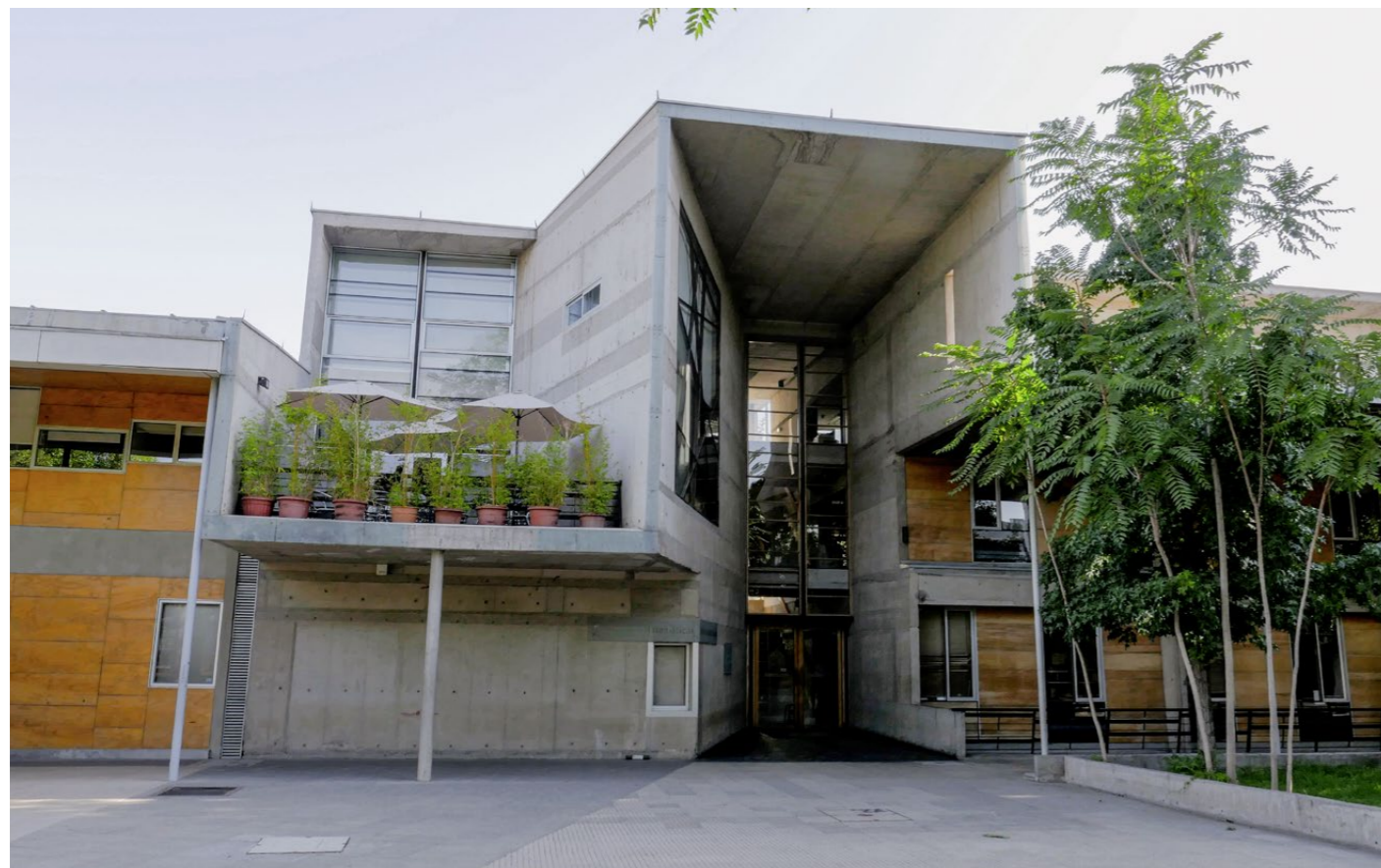
Eines von Aravenas frühen Werken ist das Gebäude der mathematischen Fakultät (1999) an der Katholischen Universität von Santiago, wo er einst selbst immatrikuliert war. Das Gebäude verbindet zwei bestehende Ensembles, wobei die komplexe Struktur des neuen Teils die Aufmerksamkeit von den unterschiedlichen Bauweisen ablenkt.
