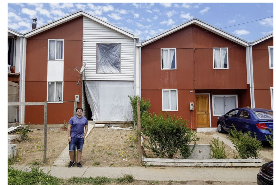
«Wir waren lange unsicher, ob wir uns den Ausbau leisten können», sagt Francisco Rodriguez. Manche Familien in «Villa Verde» wohnen deshalb bis heute in der einen Hälfte des Hauses.
