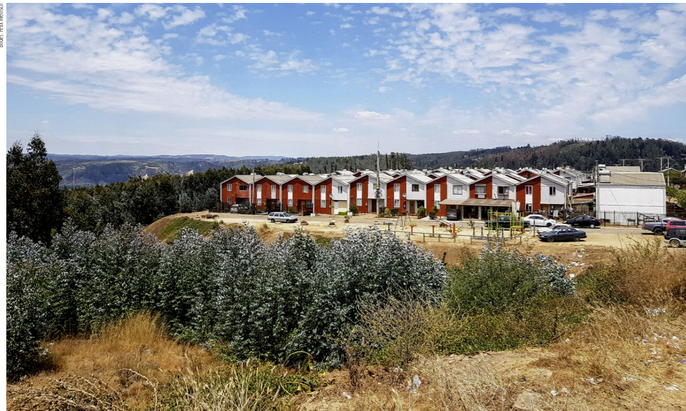
Ein Erdbeben zerstörte die chilenische Hafentstadt Constitucion fast vollständig. Als Teil des Wiederaufbaus entstand die Sozialsiedlung «Villa Verde».
