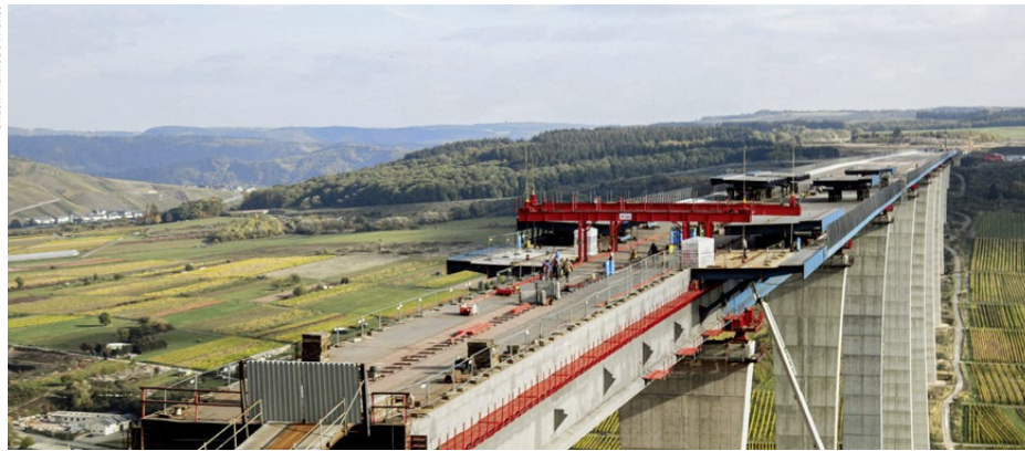
Erst nach Brückenschluss im Oktober 2018 wurden die seitlichen Kragarme an den grossen Kastenträger angefügt.
