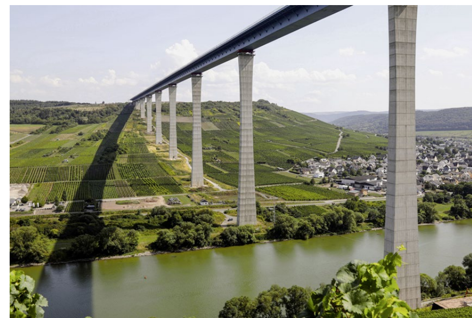
Mit dem dreizehnten Vorschub im August 2018 wurde das Auflager auf der Eifelseite erreicht und der Brückenschluss vollzogen.
