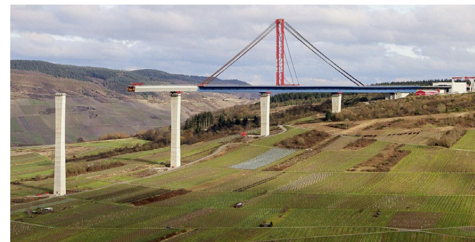
Eine weitere Aufnahme aus der fünften Vorschubphase im Februar 2016. Markant der temporäre Pylon zur Stabilisierung der Überbauauskragung, bis der nächste Pfeiler erreicht ist.
