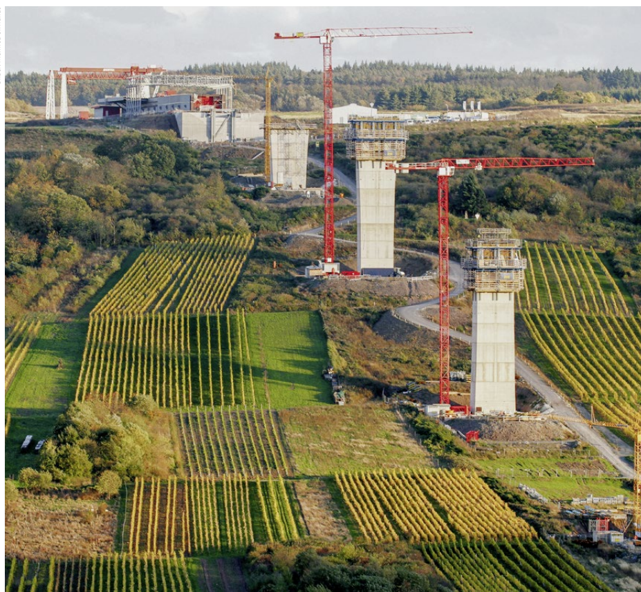
Der künftige Hochmoselübergang im Jahr 2013 mit Blick vom Westhang auf die Ostseite. Noch sind die Pfeiler nicht vollendet, der Taktkeller im Hintergrund besteht aber schon.
