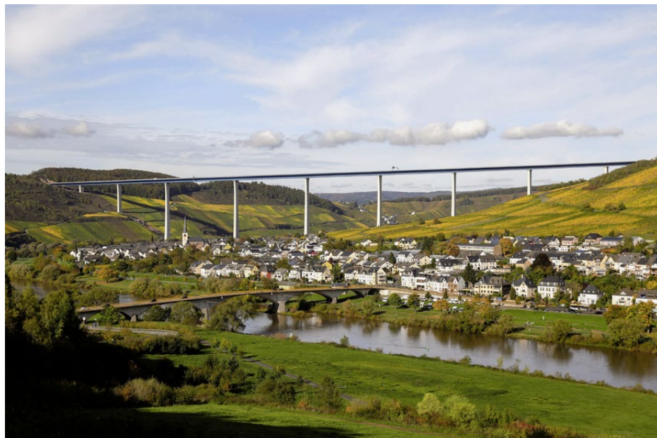
Die eigentliche Brücke war Ende Oktober 2019 vollendet, die Eröffnung der neuen Schnellstrasse erfolgte wenige Wochen später.
