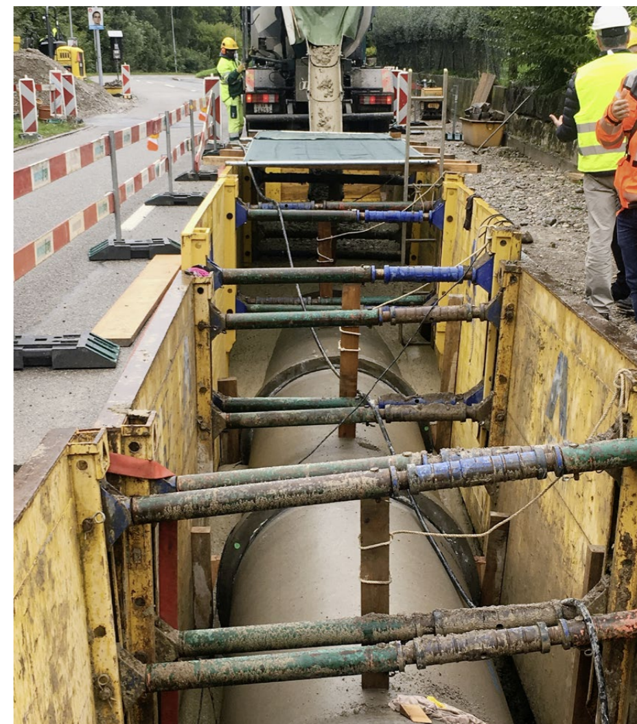
Verschiedene Anwendungen für Flüssigboden auf Schweizer Bautellen.
