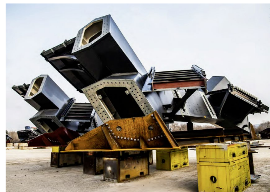
Die Stahlflächen wurden noch im zerlegten Zustand gegen Korrosion geschützt.
