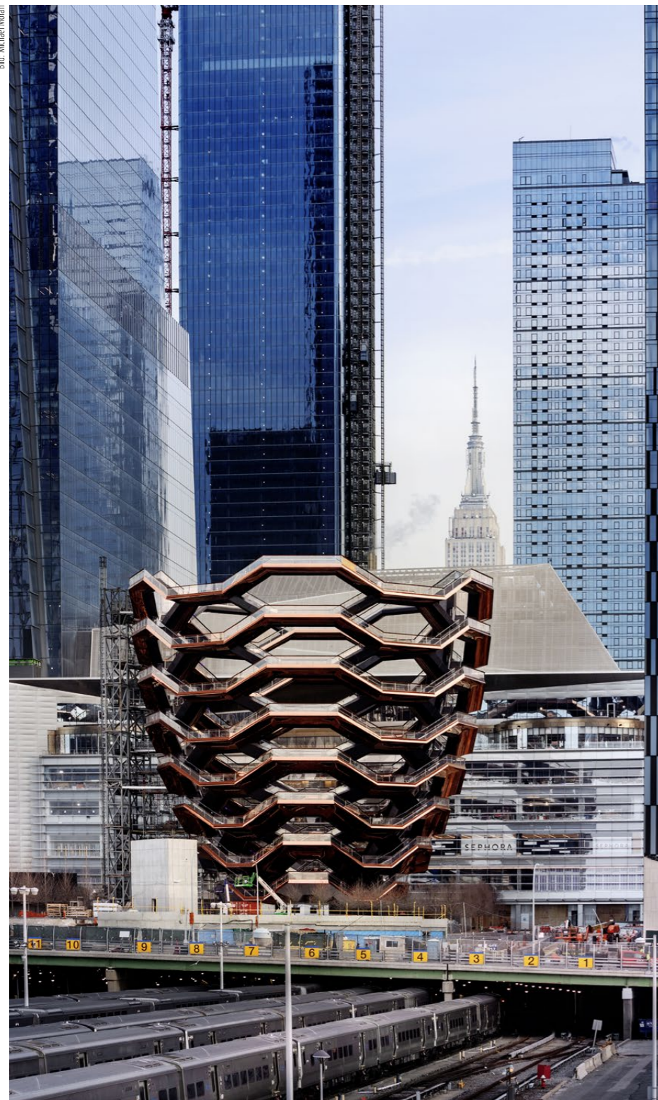
Die neue Treppenskulptur steht auf einer nachträglichen Gleisharfen-Einhausung der Penn-Station.
