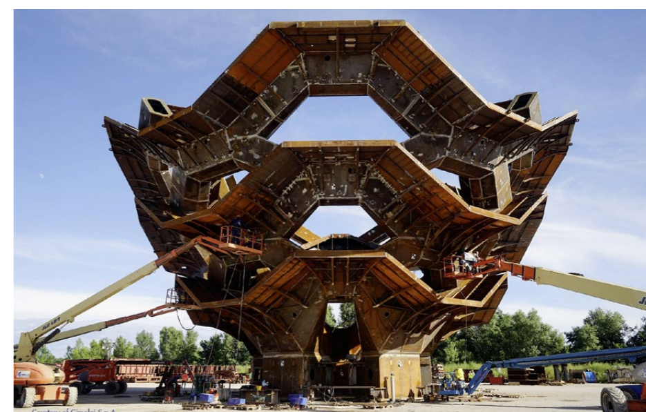
Der noch unbehandelte Sockel wurde testweise im Cimolai-Werk Roveredo zusammengesetzt.
