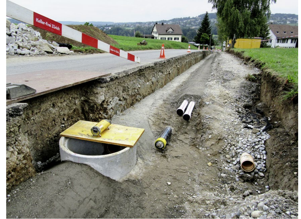
Kombinierter Graben mit Kanalisation, Sickerleitung, Elektrorohrblock und Wasserleitung: Ein Einblick in die Infrastruktur für unsere Lebensweise – auch auf dem Land.
