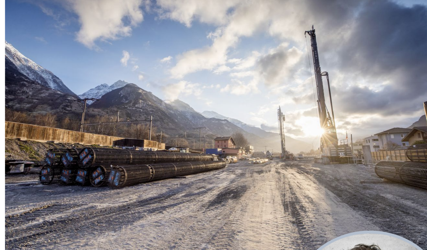
Blick von der Wanne West über den Gedeckten Einschnitt.
