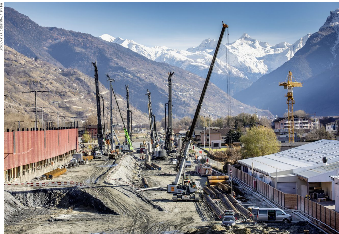
Die Wanne West zu Beginn der Pfahlarbeiten im Herbst 2018.
