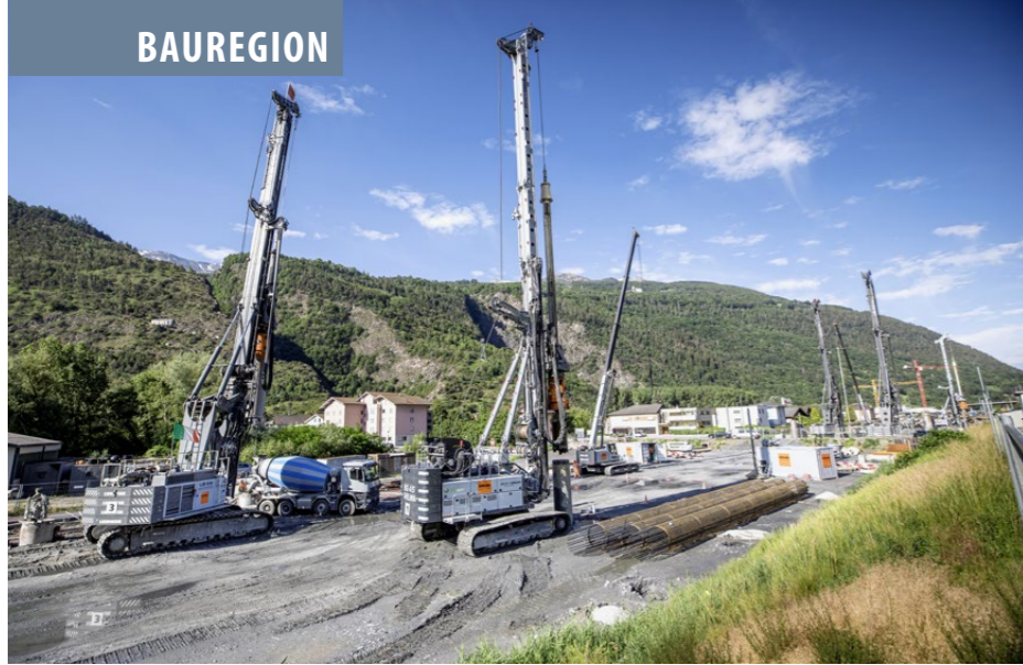
Seit zwei Jahren werden in Raron Pfähle in den Boden gebohrt.
