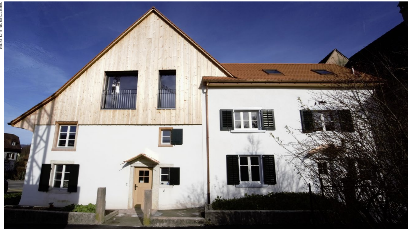
Das ehemalige Kleinbauernhaus in Breitenbach SO, 1780 bis 1800 errichtet, wurde restauriert und zu Wohnraum ausgebaut.
