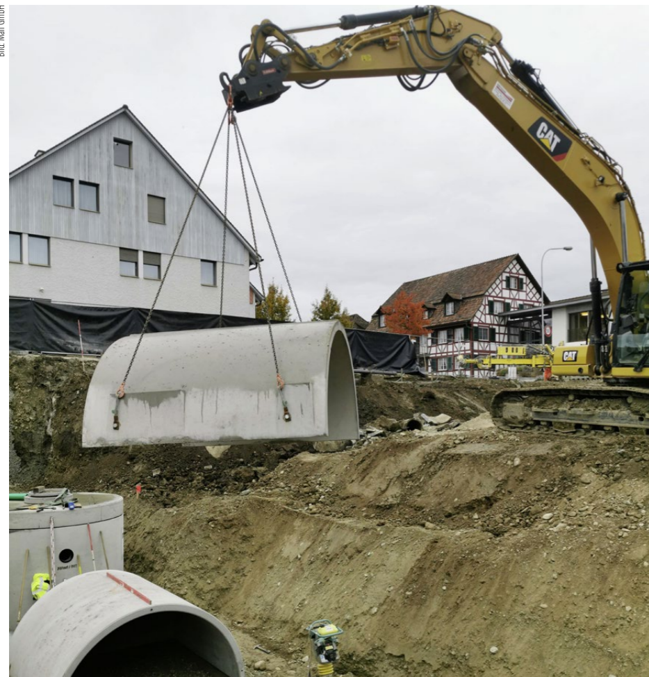
Einbau eines Sickerkies im zürcherischen Stammheim. Das von umliegenden Dachflächen stammende Regenwasser kann dort nach und nach versickern.
