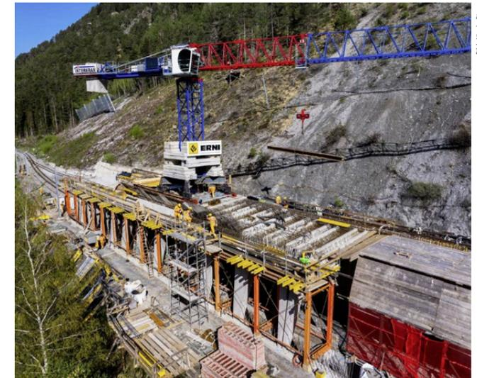
Montage der Betonfertigteile-Deckenelemente für die Galerie.
