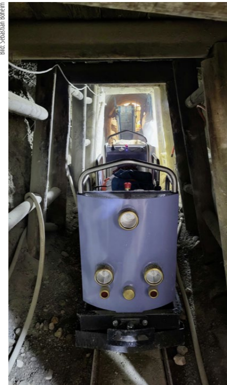
Die Gartenbahn erleichterte den Mineuren den Transport des schweren Niederbruchmaterials.
