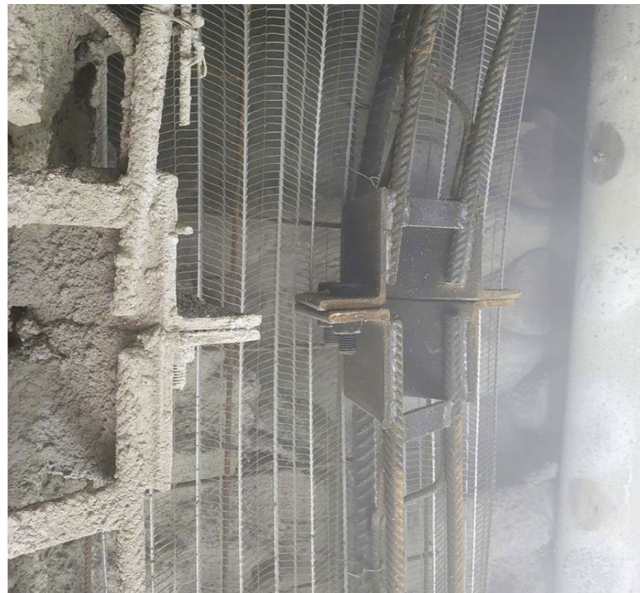
Sicherungselemente mit Gitterträger und Spritzmatten für den Aufbau der Sicherung.
