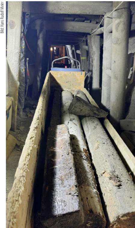
Auf einer Lohre wurde das Material von und zur Baustelle unter Tage transportiert.
