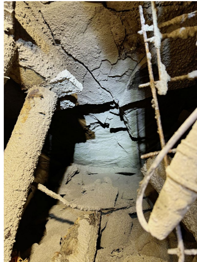
Sicherungseinbau im Bereich von Verschneidungen im bestehenden Stollenbereich.
