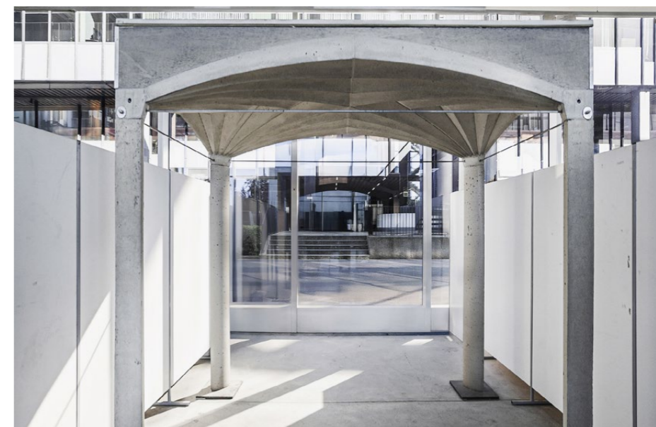
Nachhaltiges Endergebnis: Die gewölbte Betondecke ist dünner als herkömmliche Betondecken und kommt ohne integrierte Stahlbewehrung aus.
