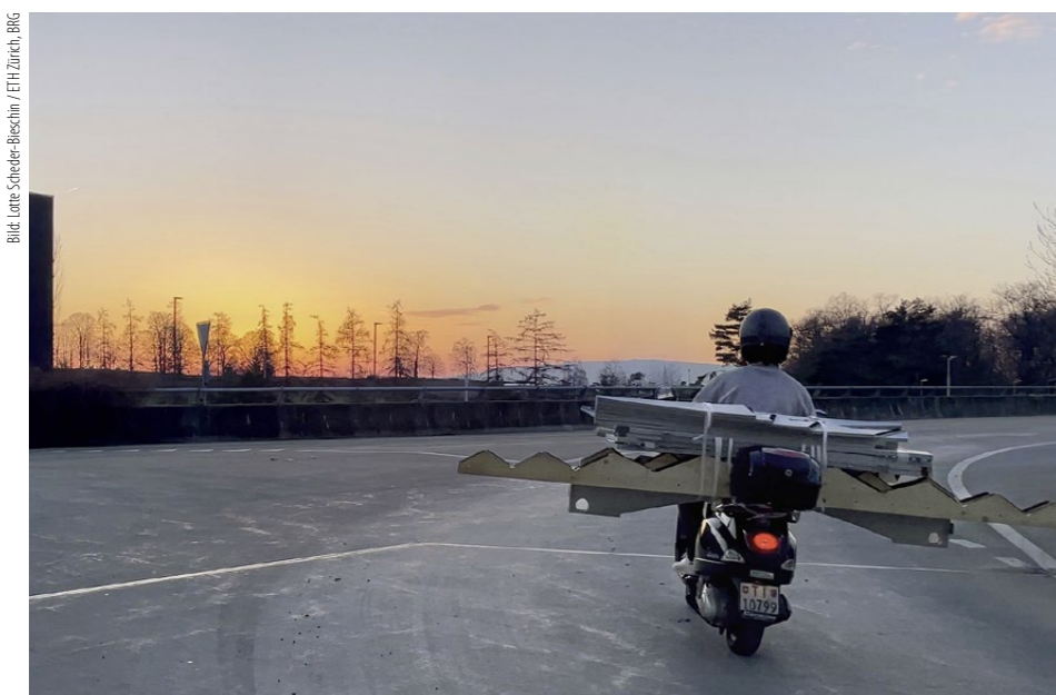
Die Einzelteile lassen sich, zusammen mit dem zerlegten Rahmen, einfach zur Baustelle transportieren.
