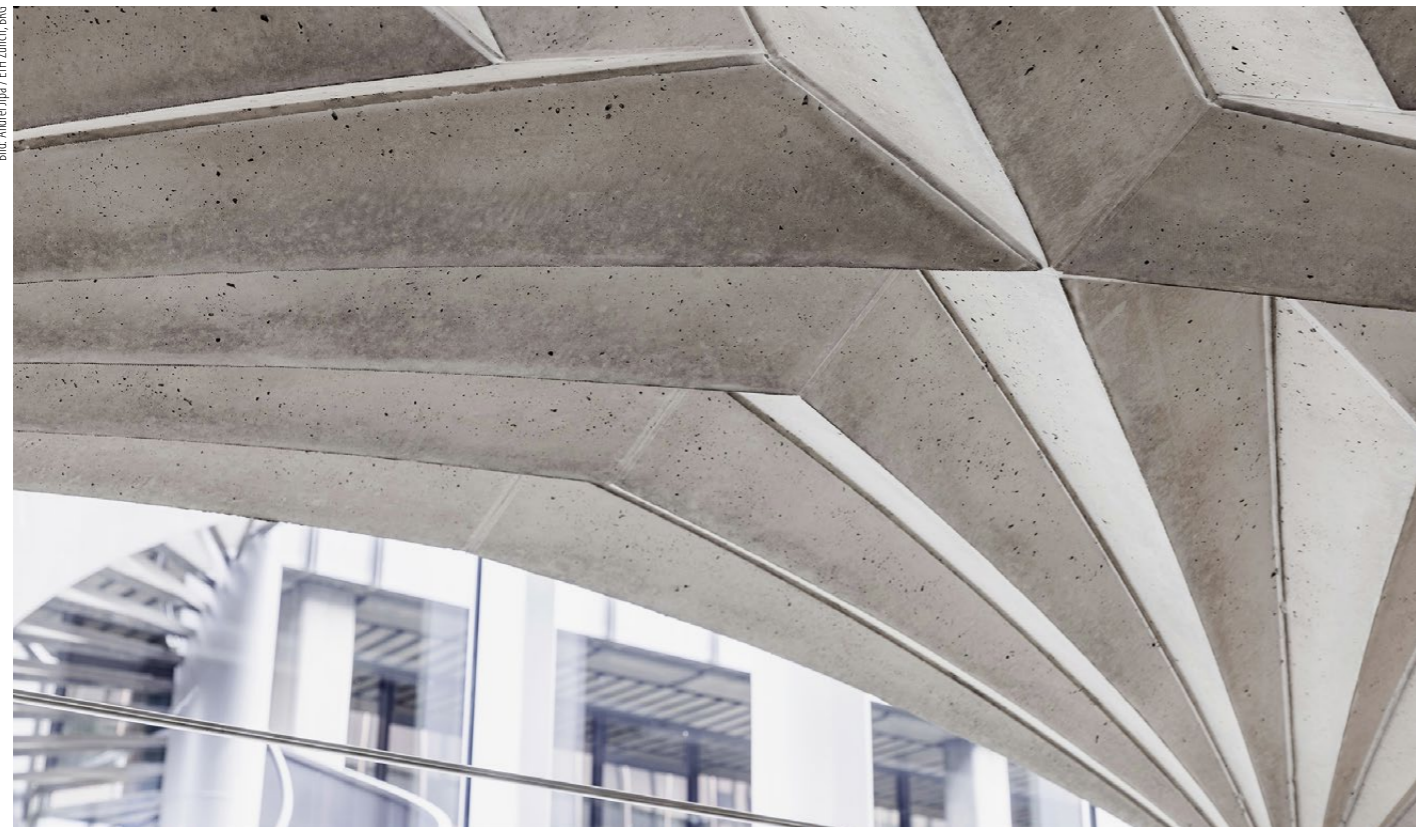
Diese Gewölbedecke aus unbewehrtem Beton entstand mit der neuartigen Schalung von Architektur-Doktorandin Lotte Scheder-Bieschin.
