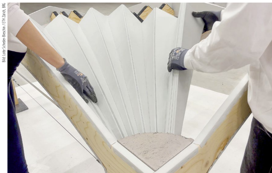
Vor Ort lassen sich die Sperrholzstreifen wie ein Fächer entfalten und werden dadurch gleichzeitig gebogen.
