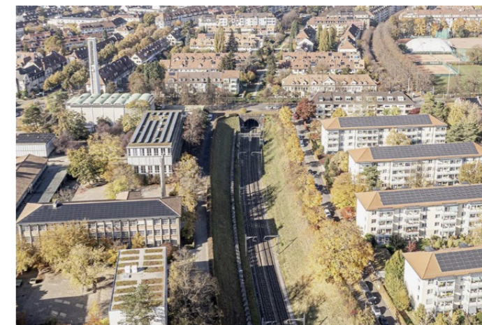
Der Schützenmatttunnel in Basel-West: Die Strecke wird für den 4-Meter-Korridor der Neat ertüchtigt.
