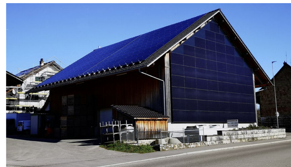
Die Photovoltaikanlagen der Solargenossenschaften werden auf öffentlichen, privaten oder landwirtschaftlichen Gebäuden errichtet.
