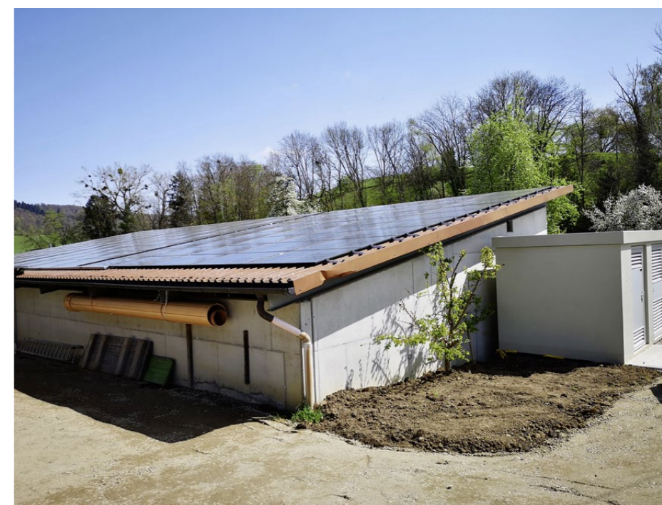
Relativ häufig scheitert ein Vorhaben an nötigen Leitungsverstärkungen oder zusätzlichen Trafostationen, die teuer und oft schwer zu bewilligen sind.
