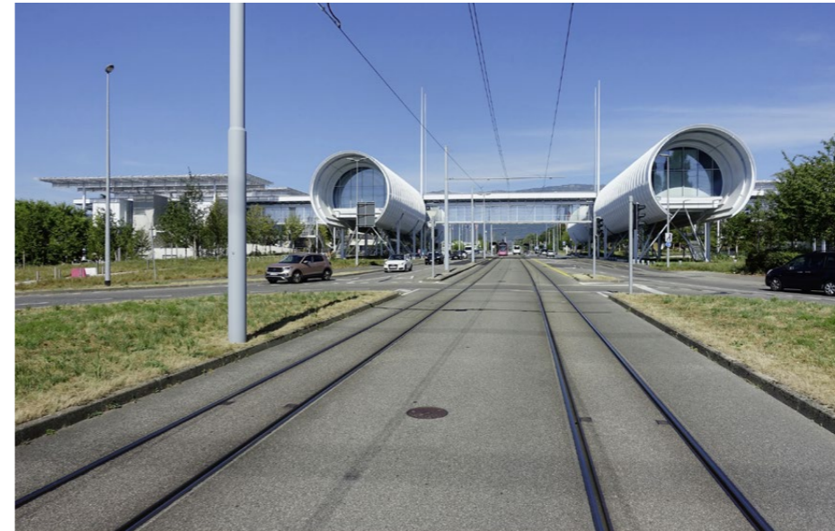
Der Science Gateway des Cern vom Renzo Piano Building Workshop ist vereint mit der Endstation der Tramlinie. Die Anlage wurde im Oktober 2023 eröffnet.
