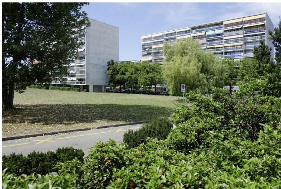
Der östliche Rand der neuen Quartiere erinnert stark an die Ville radiieuse von Le Corbusier.
