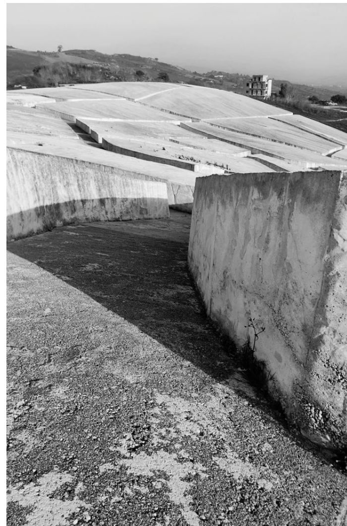
An der höchsten Stelle ist der Beton zirka 160 Zentimeter hoch. Das gesamte Land-Art-Projekt ist etwa so gross wie zwei Fussballfelder.
