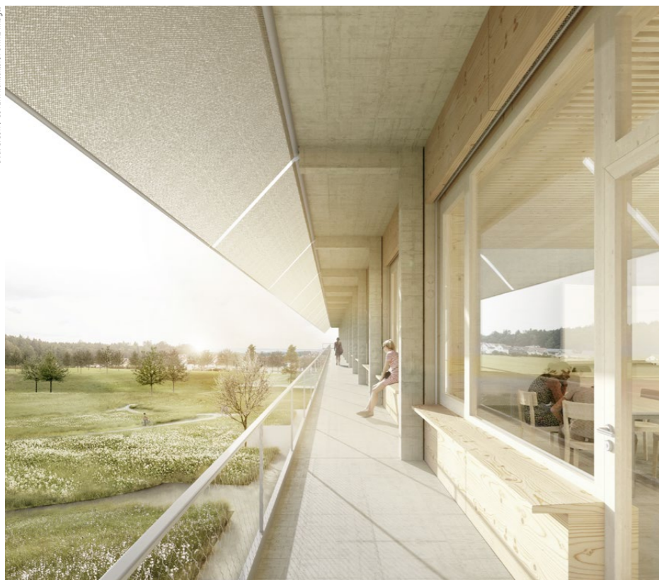
Die umlaufenden Balkone dienen als Fluchtwege und als Aufenthaltsraum.
