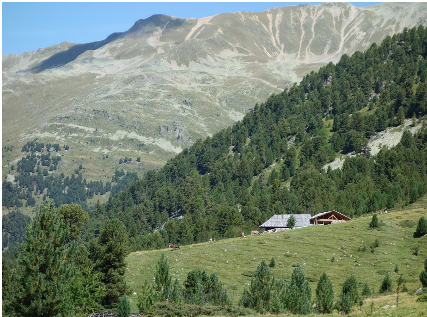
Die restaurierten Gebäude der Alp Tamangur Dadora (1777, 1810) mit Viehschermen unter Brettschindeldach, umgeben vom Naturwaldreservat Tamangur.
