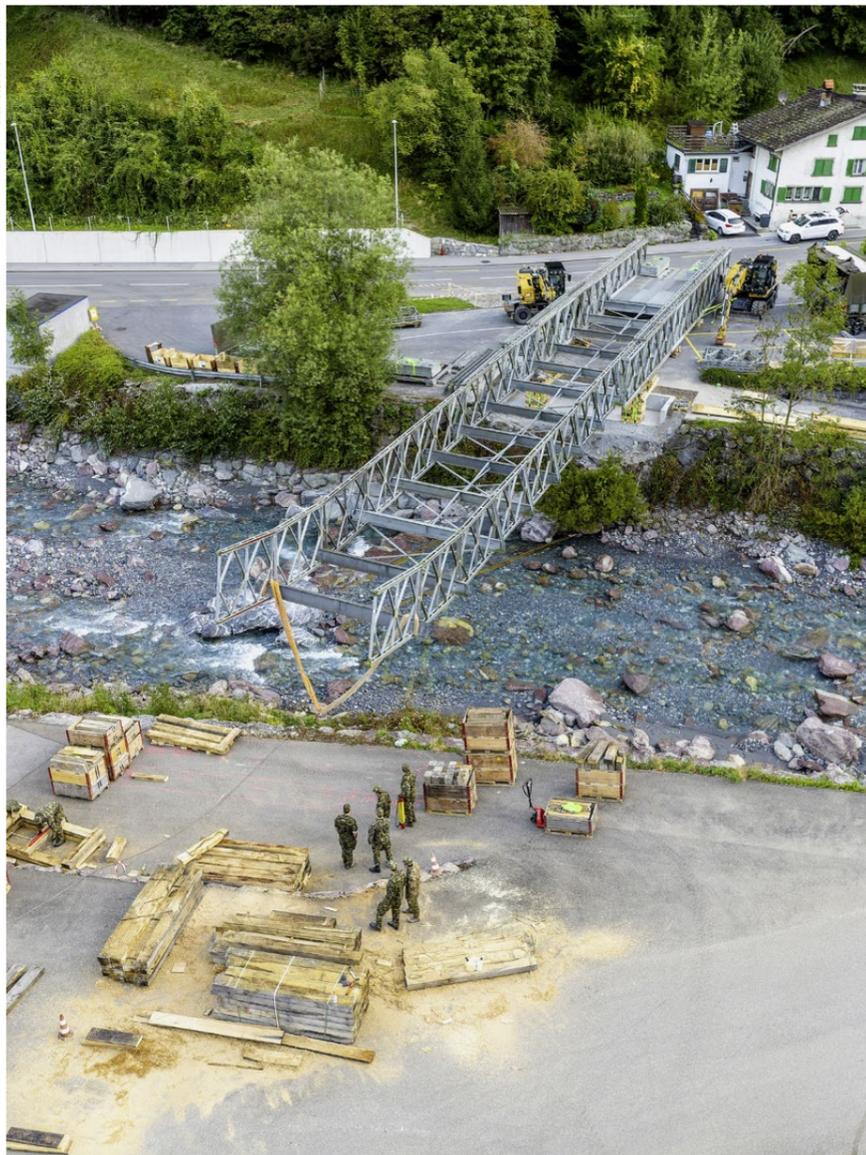
Die Brücke kurz vor der Fertigstellung: Am Ende ist sie 36 Meter lang und kann 40 Tonnen Gewicht tragen.
