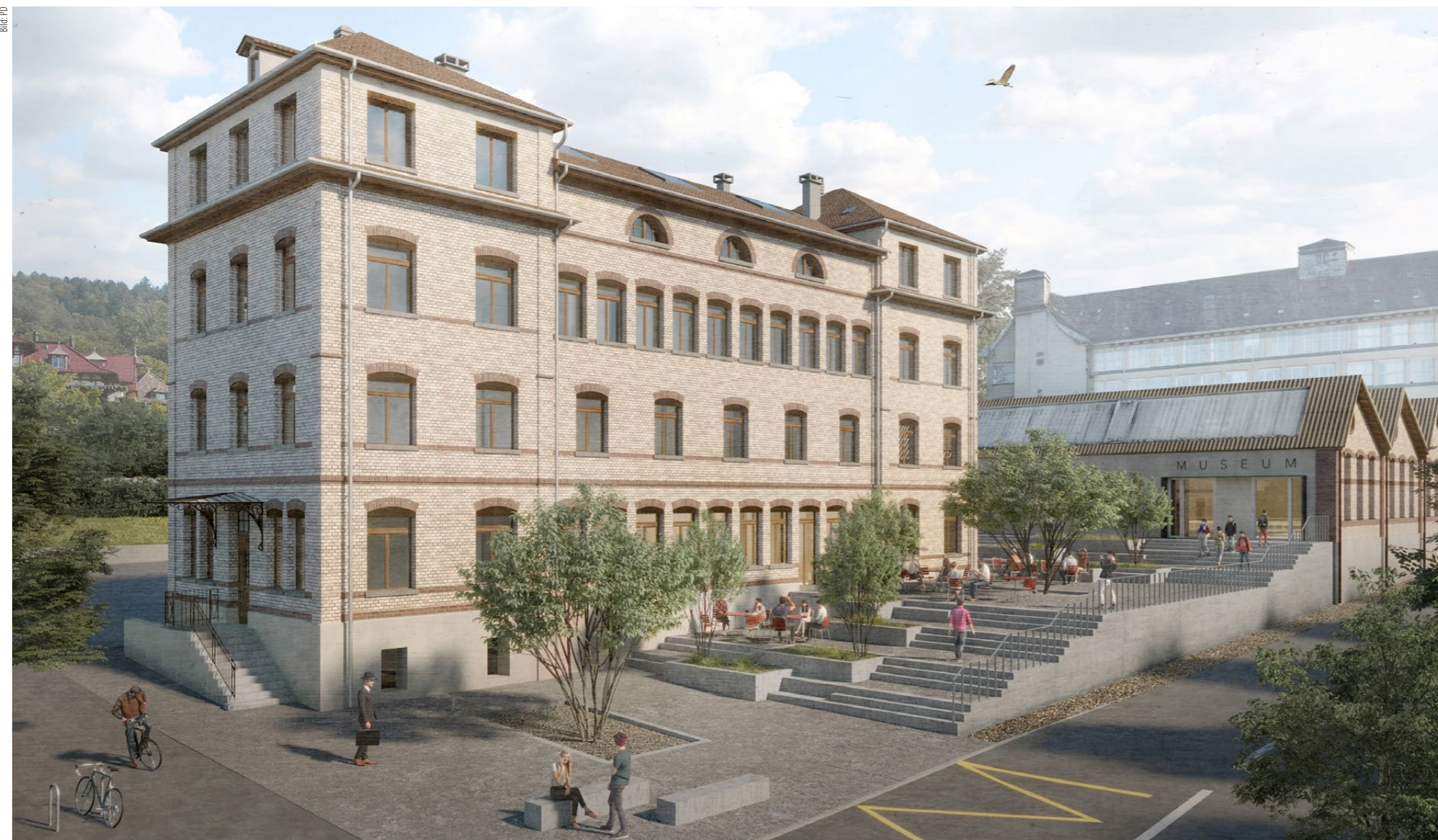
Das Theilerhaus soll in seiner Erscheinung weitgehend erhalten bleiben.
