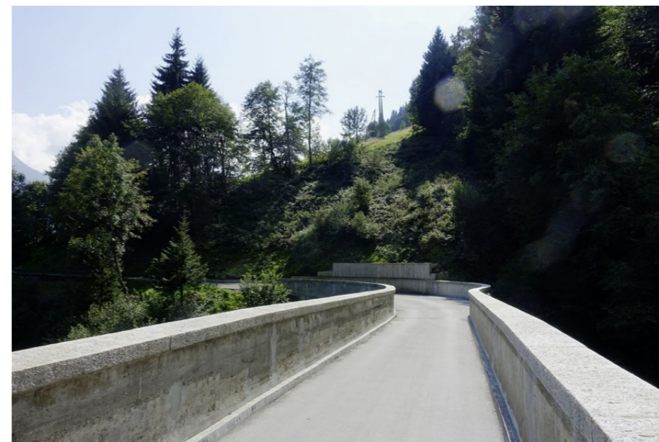
Bei der südlichen Zufahrt der Schräbhabachbrücke wurde eine kleine Ausweichstelle geschaffen.
