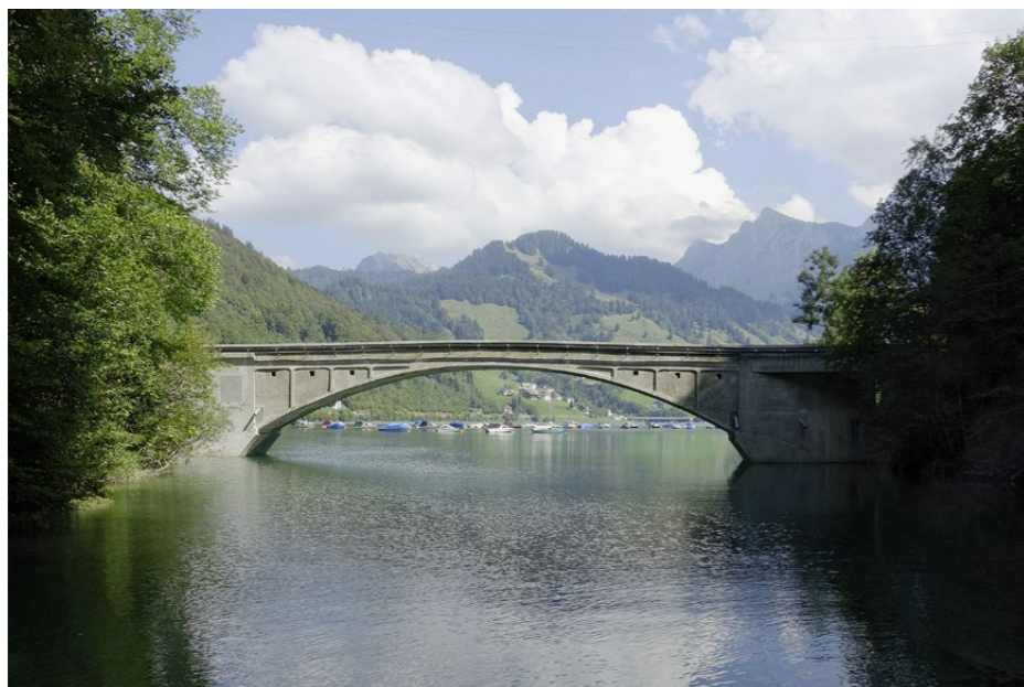
Die sanierte Schräbhabachbrücke überquert einen Seitenarm des Stausees.
