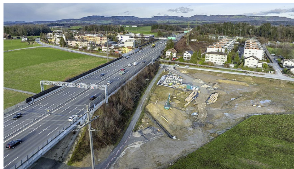
Die Vorarbeiten zur UCH sind in vollem Gang, wie die Baudirektion in einer Mitteilung schreibt.
