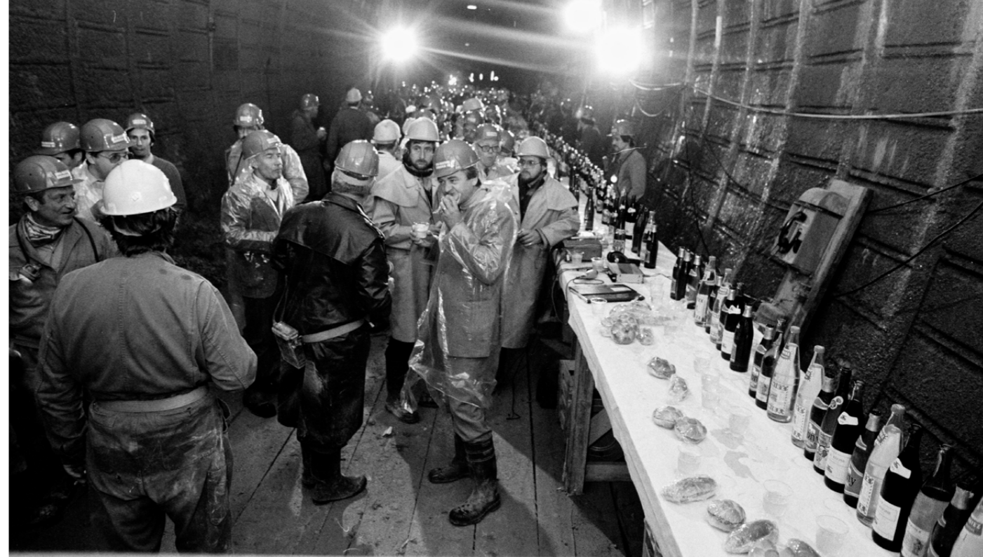
Freude über den Furka-Basistunnel nach dem Durchstich. Der Bund jedoch war aufgrund der langen Dauer und den überbordenden Kosten erschüttert.
