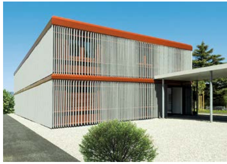
Bürogebäude mit eleganter Fassade: Dass dahinter Container stecken, ist bei diesem Ausbaustandard nicht mehr erkennbar.
