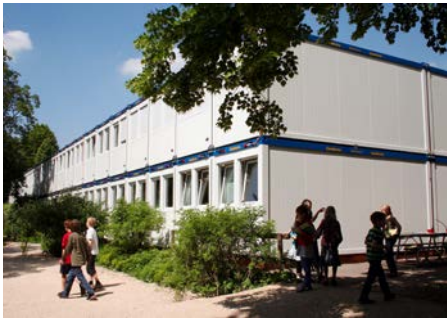
Eine Container-Schulanlage im Grossformat: Sinkt der Bedarf an Schulraum, können die Module abmontiert und erneut genutzt werden.
