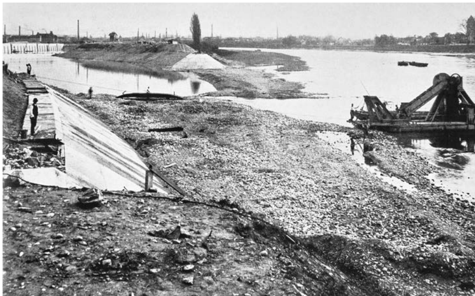
Ganz zu Beginn der Bauarbeiten: Im Fluss wird Erde für den zu errichtenden Quai aufgeschüttet.
