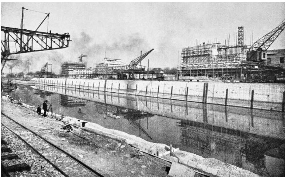
Aus den 1920er-Jahren: Das Hafenbecken ist fertig. An seinem inneren Rand entstehen die Hafengebäude, unter anderem der heute noch existierende, 45 Meter hohe Siloturm.
